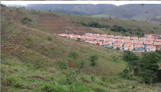
Foto: 1636721697901.jpg ID: 33 Visão geral do setor, Talude de corte com solo exposto
