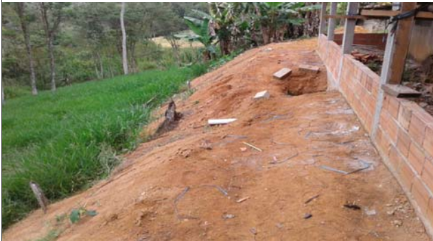
Foto: 1636638511716.jpg ID: 12 Presença de talude de aterro lançado
