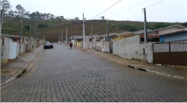
Foto: 1636721065114.jpg ID: 31 Visão geral do setor, Talude de corte com solo exposto
