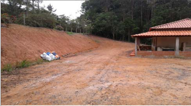
Foto: 1636638408355.jpg ID: 11 Talude de corte com solo exposto
