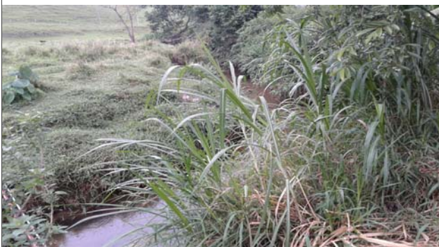
Foto: 1636644488619.jpg ID: 13 Visão geral da drenagem
