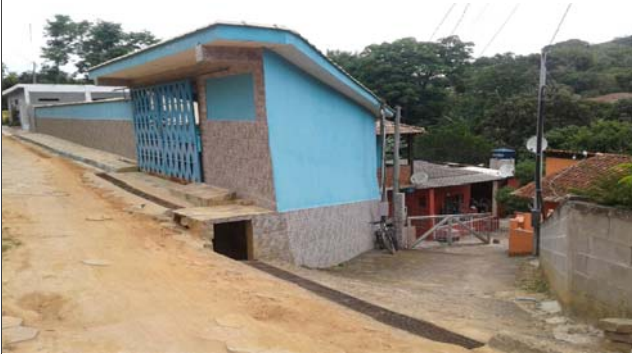
Foto: 1637241219544.jpg ID: 32 Visão geral do setor, Moradia sujeita a risco de escorregamento
