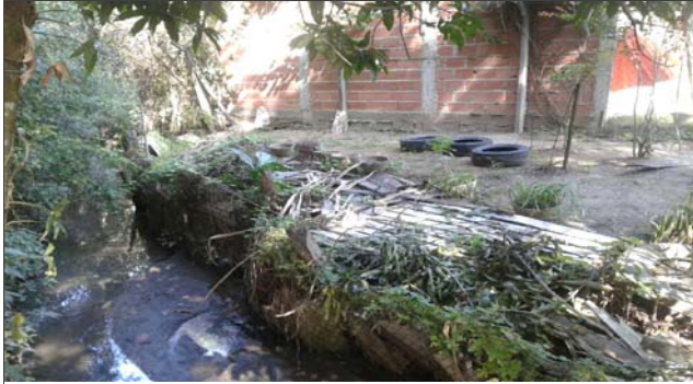
Foto: 1653491191746.jpg ID: 11 Visão geral do setor, Visão geral da drenagem, Detalhe do canal
