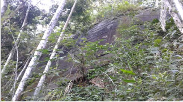
Foto: 1653329595973.jpg ID: 11 Visão geral do setor, Evidência de movimentação no terreno,
