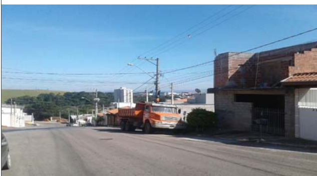
Foto: 1653659564612.jpg ID: 15 Visão geral do setor, Moradia sujeita a processos de erosão
