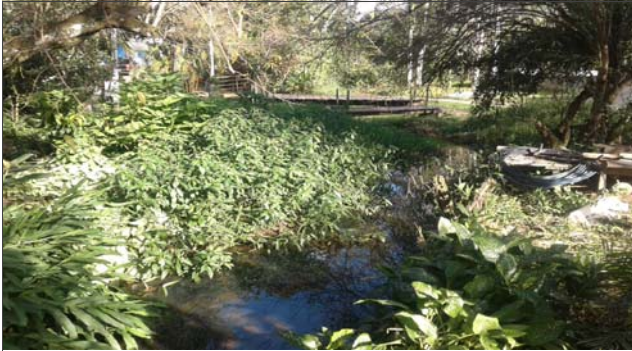
Foto: 1653588856137.jpg ID: 11 Detalhe do canal
