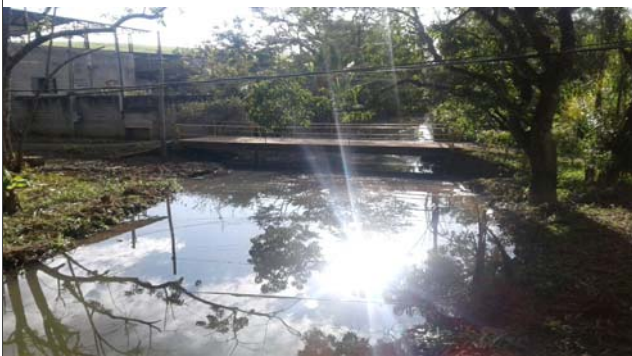
Foto: 1653589641360.jpg ID: 13 Detalhe do canal
