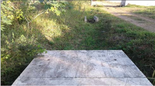
Foto: 1653420635941.jpg ID: 11 Detalhe do canal, Detalhe para intervenções no canal
