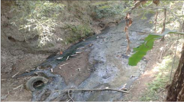
Foto: 1653583894124.jpg ID: 11 Detalhe do canal
