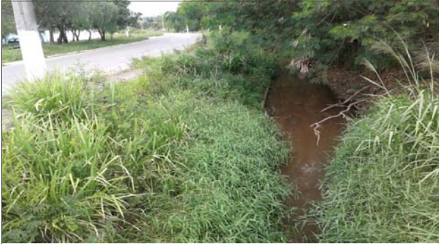
Foto: 1652970215210.jpg ID: 11 Visão geral da drenagem, Detalhe do canal
