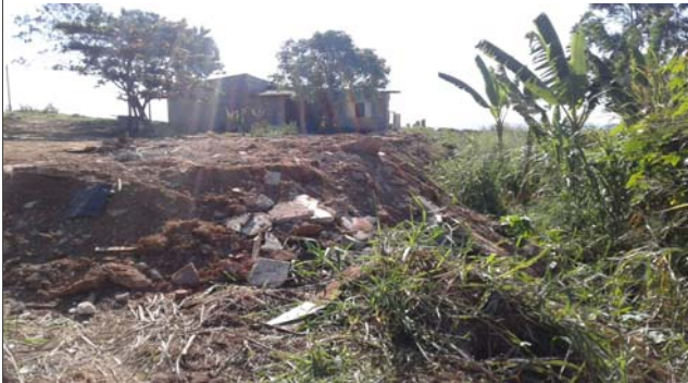
Foto: 1653412433261.jpg ID: 12 Talude de aterro inconsolidado
