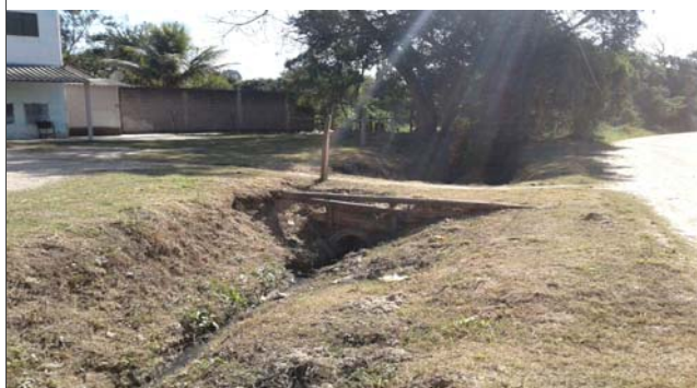
Foto: 1653399368586.jpg ID: 13 Visão geral da drenagem
