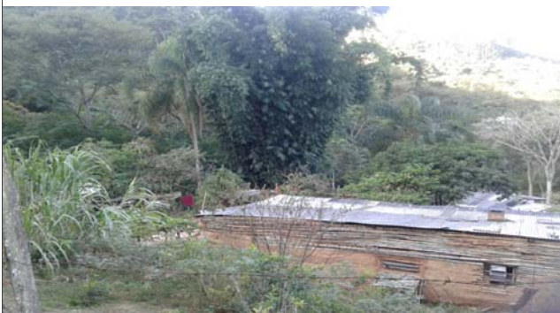
Foto: 1653331653560.jpg ID: 13 Moradia sujeita a risco de rolamento de blocos
