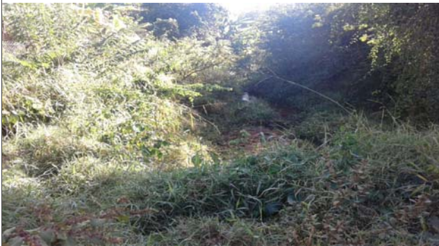
Foto: 1653567434950.jpg ID: 12 Visão geral da drenagem
