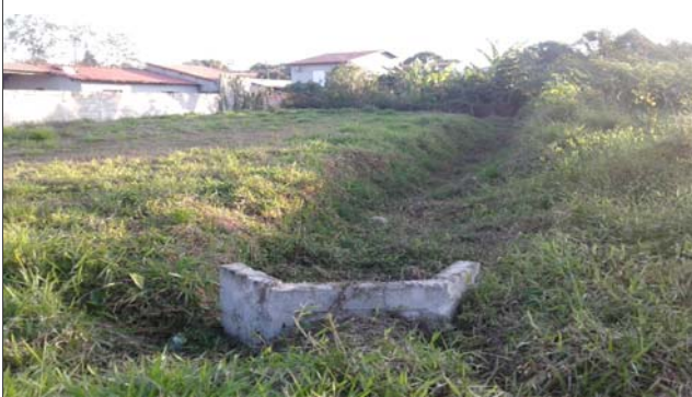
Foto: 1653420678552.jpg ID: 12 Visão geral da drenagem
