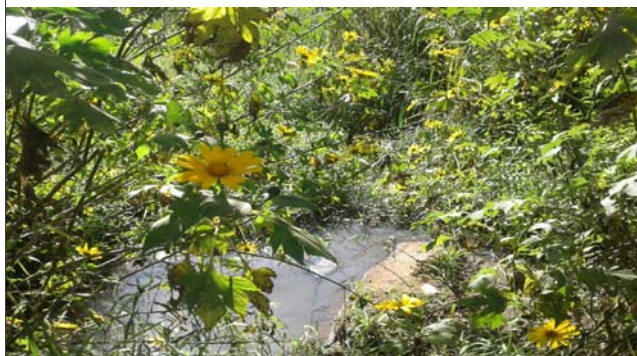
Foto: 1653667570388.jpg ID: 13 Visão geral da drenagem, Detalhe do canal
