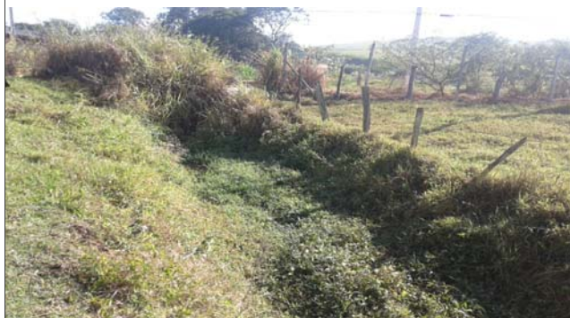
Foto: 1653050294708.jpg ID: 12 Visão geral da drenagem
