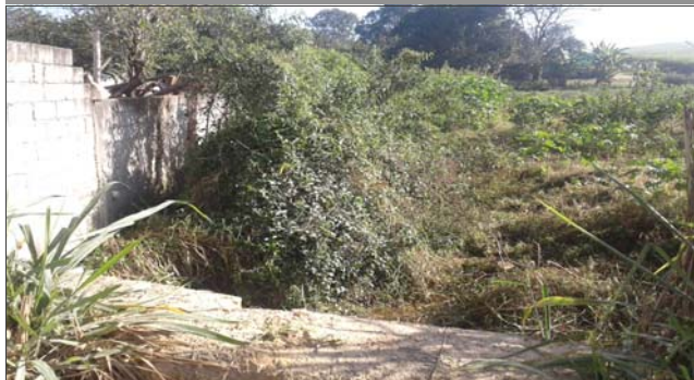
Foto: 1653049108420.jpg ID: 11 Visão geral da drenagem
