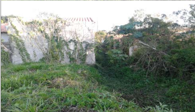
Foto: 1653420995893.jpg ID: 13 Detalhe do canal
