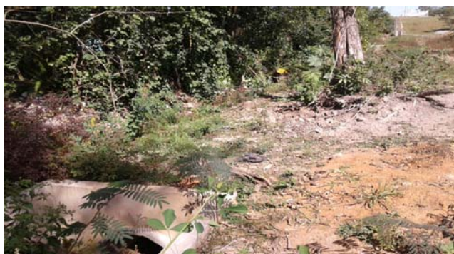
Foto: 1653402999002.jpg ID: 15 Visão geral da área, Detalhe para intervenções no canal
