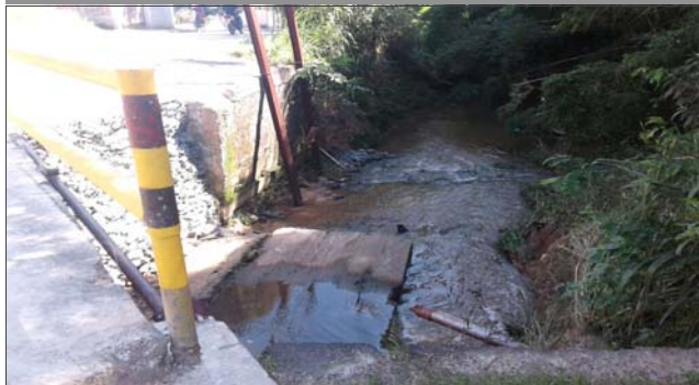
Foto: 1640084100164.jpg ID: 11 Visão geral da drenagem
