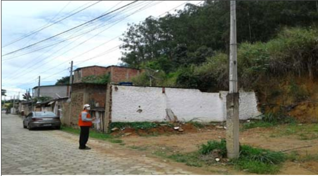
Foto: 1641214946468.jpg ID: 11 Visão geral do setor, Formação de processo erosivo, Talude de corte com solo exposto
