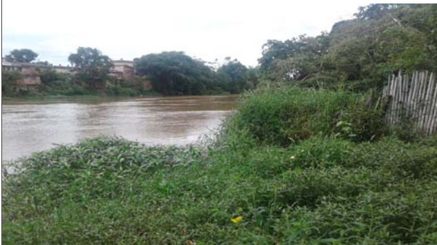
Foto: 1641385680557.jpg ID: 13 Visão geral da drenagem,
