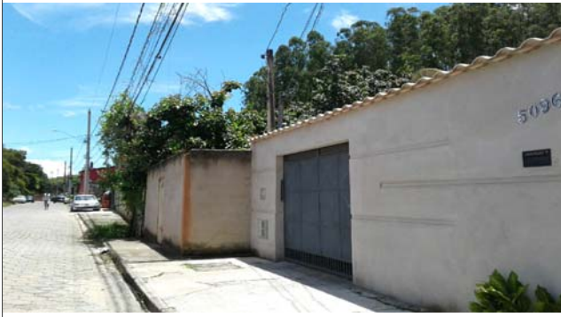
Foto: 1641220708922.jpg ID: 32 Moradia sujeita a risco de escorregamento
