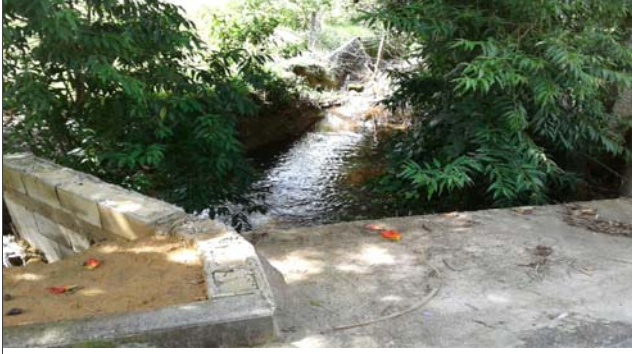
Foto: 1641227716277.jpg ID: 11 Visão geral da drenagem, Vista para jusante
