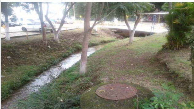
Foto: 1641302414103.jpg ID: 24 Visão geral da drenagem,
