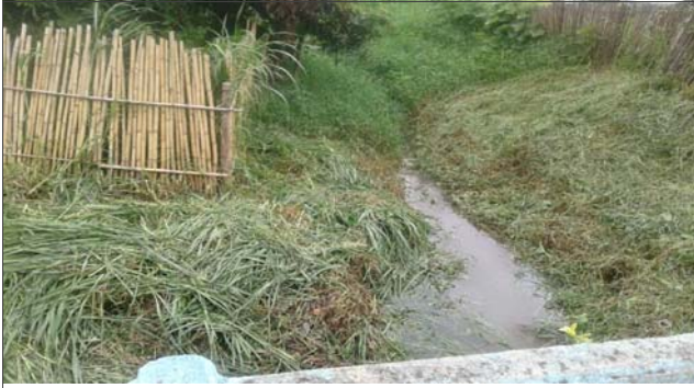
Foto: 1641302053838.jpg ID: 21 Visão geral da drenagem, Vista para montante
