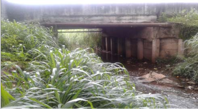
Foto: 1641295667538.jpg ID: 11 Visão geral da drenagem
