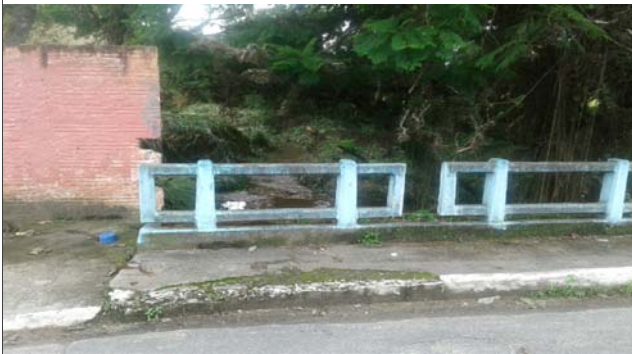
Foto: 1641302199777.jpg ID: 22 Visão geral da drenagem, detalhe para intervenções no canal,
