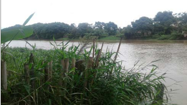
Foto: 1641385770100.jpg ID: 14 Visão geral da drenagem,
