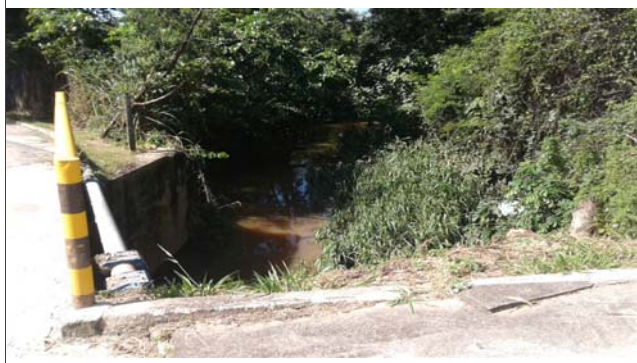
Foto: 1640084889452.jpg ID: 12 Visão geral da drenagem
