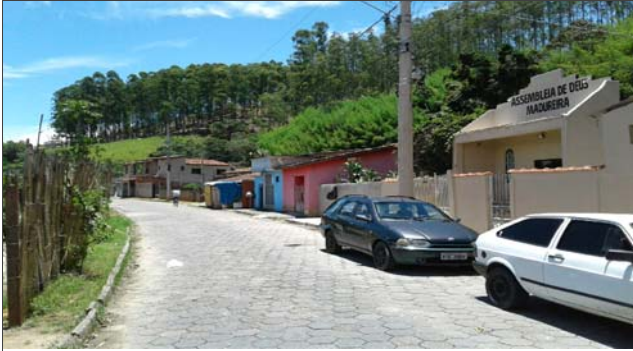
Foto: 1641219958159.jpg ID: 31 Visão geral do setor, Moradia sujeita a risco de escorregamento
