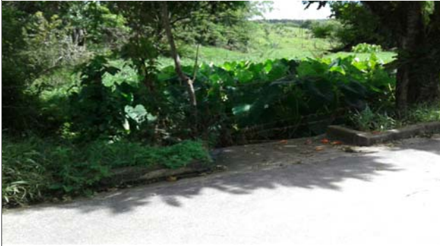
Foto: 1641227847726.jpg ID: 12 Visão geral da drenagem, detalhe para intervenções no canal,
