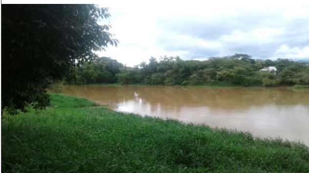
Foto: 1641318451923.jpg ID: 15 Visão geral da drenagem,
