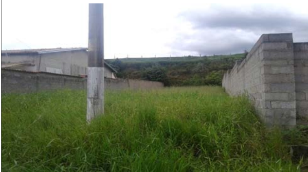
Foto: 1641401000576.jpg ID: 43 Visão geral do setor, Talude de corte com solo exposto
