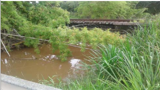
Foto: 1641404798133.jpg ID: 14 Visão geral da drenagem,
