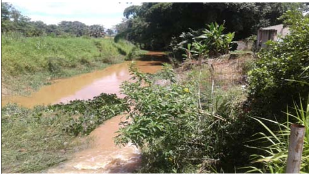
Foto: 1641475001171.jpg ID: 43 Visão geral da drenagem,
