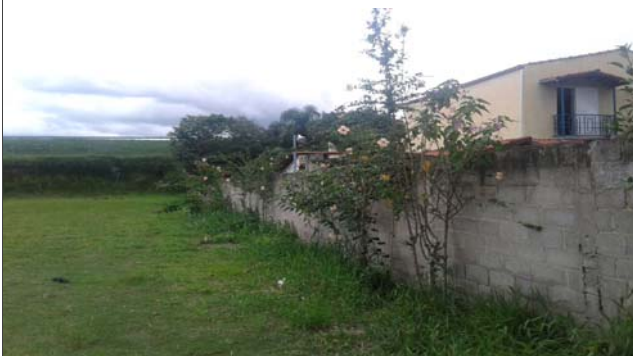
Foto: 1641401473201.jpg ID: 44 Moradia sujeita a risco de escorregamento
