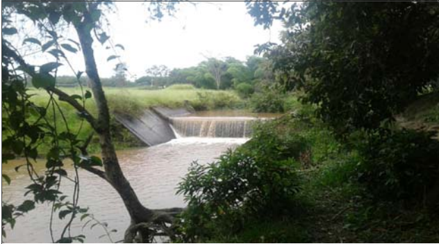
Foto: 1641404507078.jpg ID: 11 detalhe para intervenções no canal, Barragem
