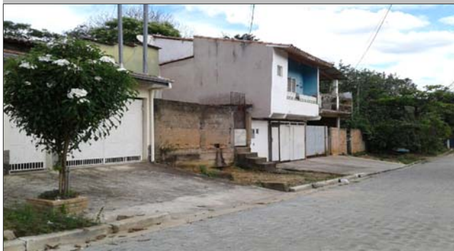
Foto: 1639675527665.jpg ID: 91 Moradia sujeita a risco de escorregamento
