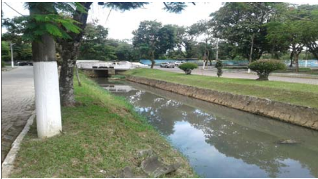
Foto: 1639499618970.jpg ID: 34 Visão geral da drenagem,
