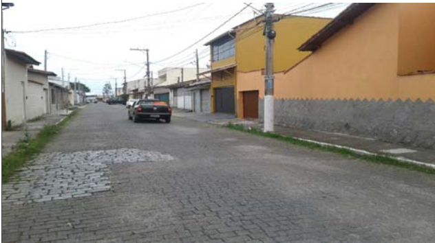
Foto: 1639481309531.jpg ID: 12 Imóveis afetados pelo processo
