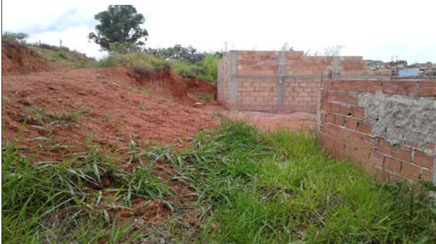
Foto: 1639574542259.jpg ID: 33 Talude de corte com solo exposto
