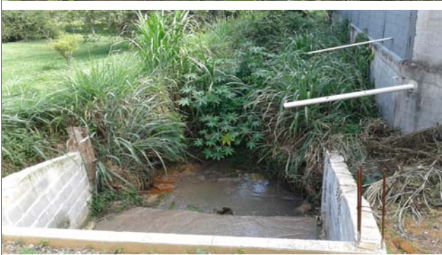
Foto: 1638810154614.jpg ID: 13 Visão geral da drenagem
