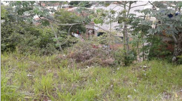
Foto: 1639574868183.jpg ID: 32 Moradia sujeita a risco de escorregamento, Talude de corte com solo exposto
