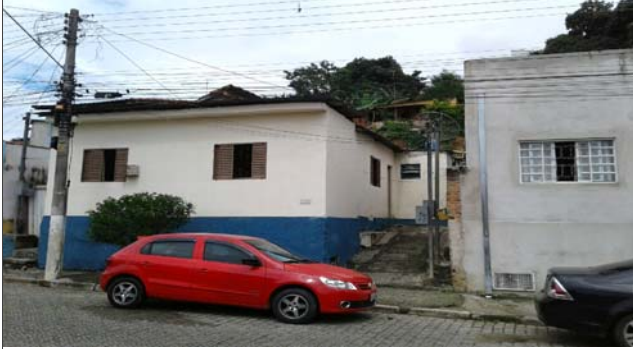
Foto: 1639741494221.jpg ID: 21 Visão geral do setor, Moradia sujeita a risco de escorregamento
