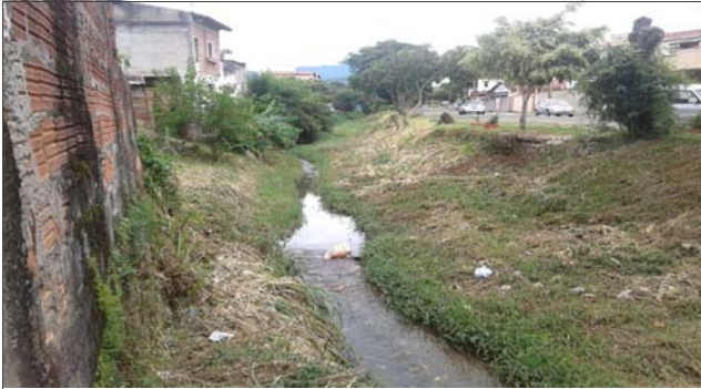
Foto: 1639483039348.jpg ID: 21 Visão geral da drenagem, Vista para montante
