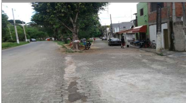
Foto: 1639073460726.jpg ID: 21 Imóveis afetados pelo processo
