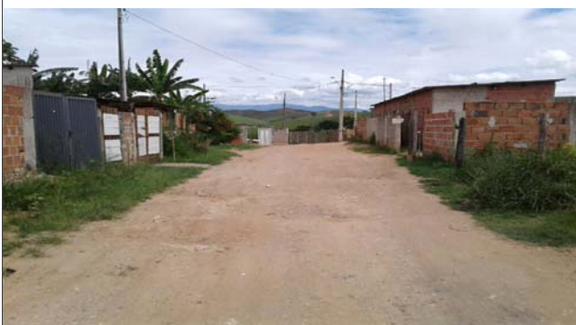
Foto: 1639669365036.jpg ID: 63 Visão geral do setor, Moradia sujeita a risco de escorregamento
