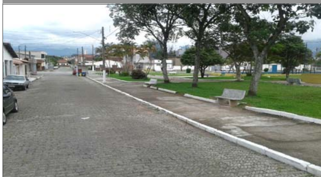
Foto: 1639566272003.jpg ID: 11 Visão geral da área, Imóveis afetados pelo processo
