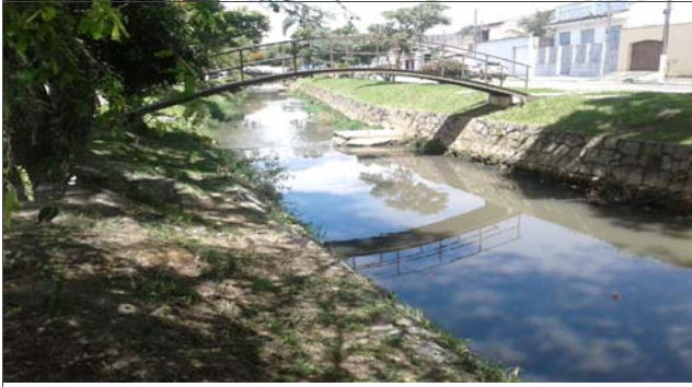
Foto: 1639495893506.jpg ID: 31 Visão geral da drenagem, Vista para jusante
