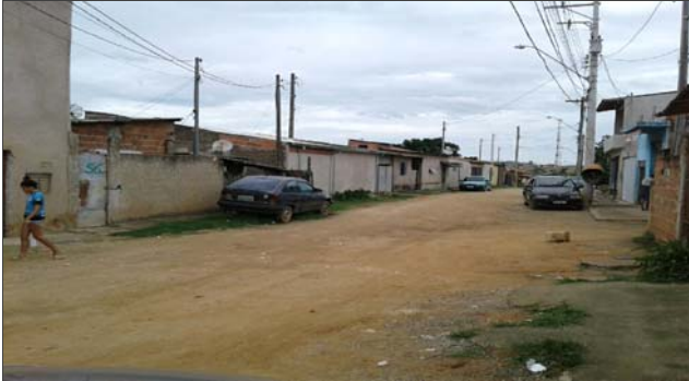
Foto: 1639657943073.jpg ID: 31 Visão geral do setor, Moradia sujeita a risco de escorregamento
