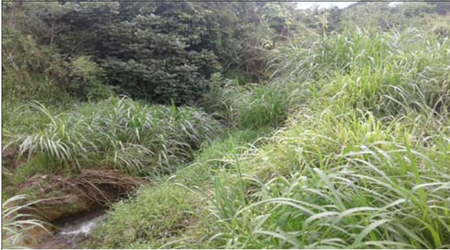
Foto: 1639481086220.jpg ID: 11 Visão geral da drenagem
