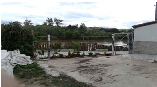
Foto: 1639072835432.jpg ID: 14 Visão geral da drenagem, Imóveis afetados pelo processo
