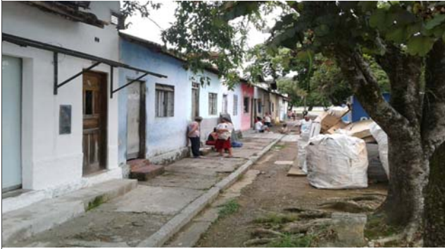
Foto: 1639592759975.jpg ID: 82 Imóveis afetados pelo processo
