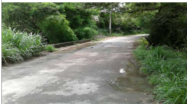
Foto: 1639746091603.jpg ID: 15 detalhe para intervenções no canal,
