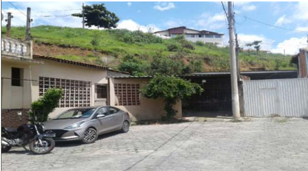
Foto: 1639139788972.jpg ID: 12 Visão geral do setor, Moradia sujeita a risco de escorregamento
