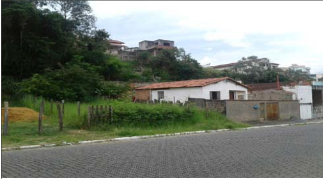
Foto: 1639507510465.jpg ID: 61 Visão geral do setor, Moradia sujeita a risco de escorregamento
