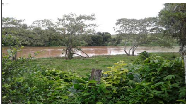
Foto: 1639584189581.jpg ID: 52 Visão geral da drenagem,
