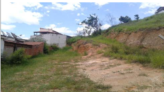
Foto: 1639140507918.jpg ID: 13 Visão geral do setor, Talude de corte com solo exposto
