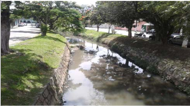
Foto: 1639499539299.jpg ID: 33 Visão geral da drenagem,
