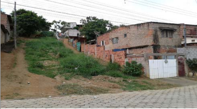
Foto: 1639656428991.jpg ID: 21 Visão geral do setor, Moradia sujeita a risco de escorregamento
