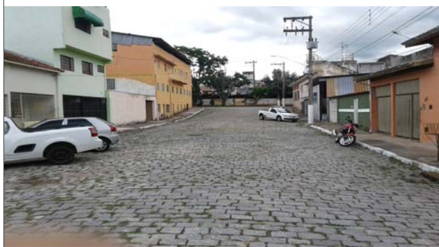
Foto: 1639072971867.jpg ID: 24 Imóveis afetados pelo processo
