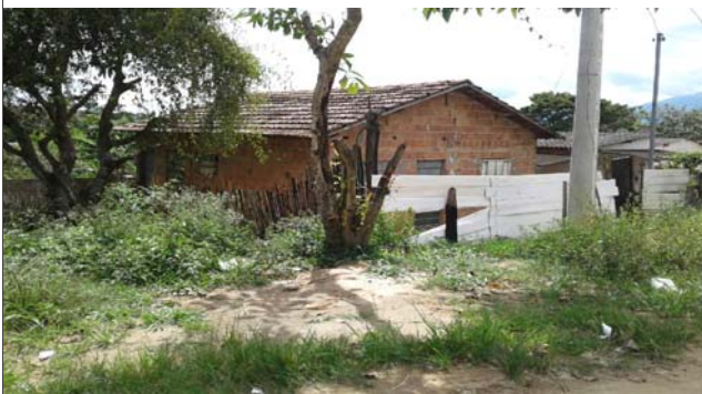
Foto: 1639671455893.jpg ID: 73 Talude de corte com solo exposto
