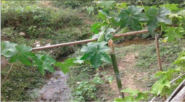
Foto: 1638808609843.jpg ID: 11 Detalhe do canal
