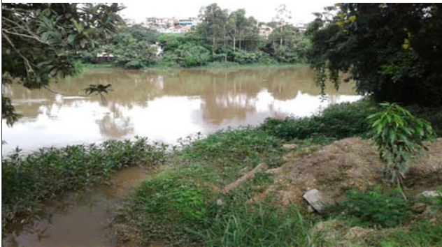
Foto: 1639679014612.jpg ID: 42 Visão geral da drenagem,
