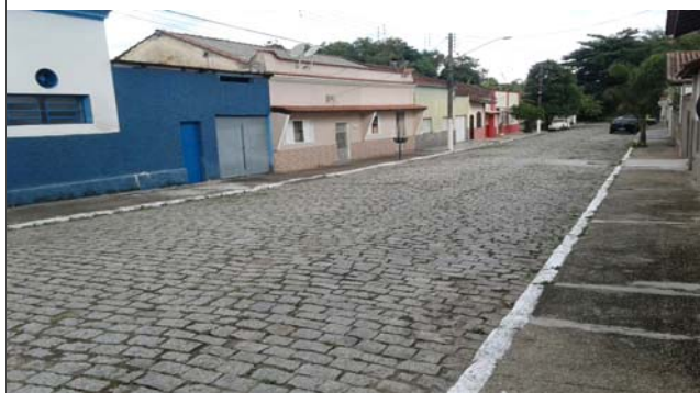
Foto: 1639073311120.jpg ID: 23 Imóveis afetados pelo processo
