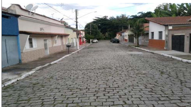
Foto: 1639072807809.jpg ID: 12 Imóveis afetados pelo processo
