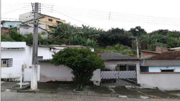
Foto: 1639740081825.jpg ID: 15 Visão geral do setor, Talude natural
