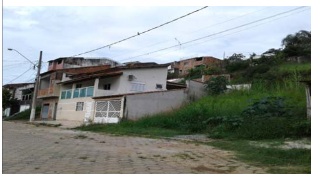
Foto: 1639675711826.jpg ID: 94 Visão geral do setor, Talude natural
