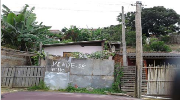
Foto: 1639658243015.jpg ID: 33 Visão geral do setor, Talude de corte
