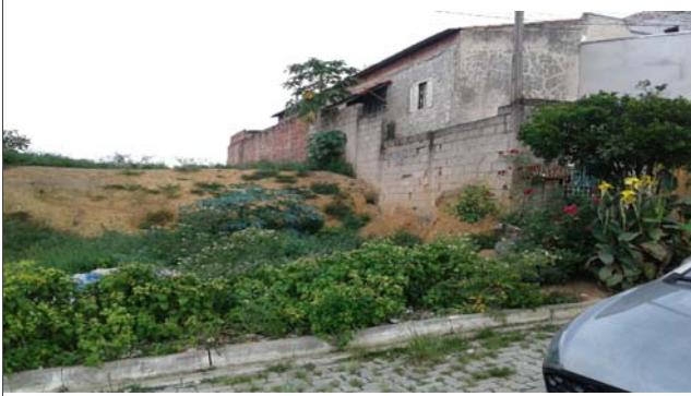
Foto: 1639676237696.jpg ID: 12 Visão geral do setor, Corte mostrando a inclinação do setor
