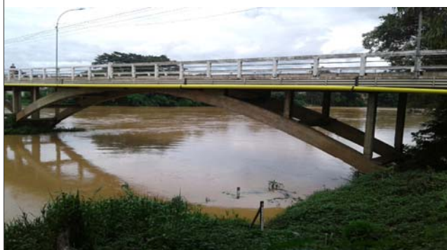
Foto: 1639571708187.jpg ID: 15 Visão geral da drenagem, Detalhe do canal, detalhe para intervenções no canal,
