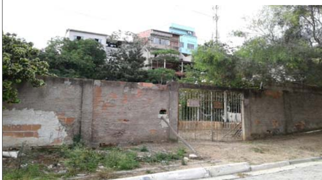
Foto: 1639675622265.jpg ID: 92 Visão geral do setor, Moradia sujeita a risco de escorregamento
