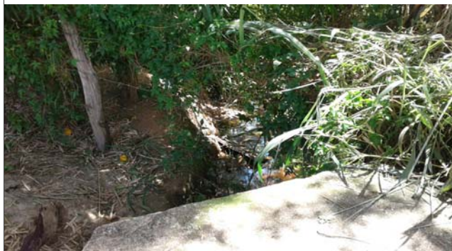
Foto: 1640100365576.jpg ID: 12 Detalhe do canal
