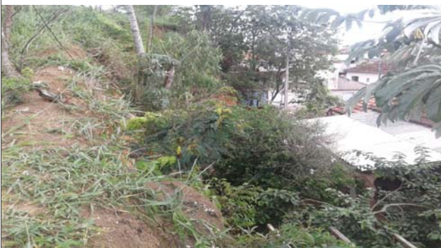
Foto: 1639417519267.jpg ID: 33 Visão geral do setor, Talude de corte com solo exposto
