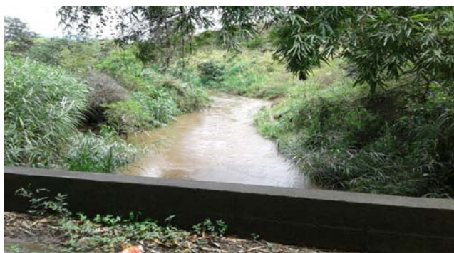
Foto: 1639745623299.jpg ID: 12 Visão geral da drenagem,
