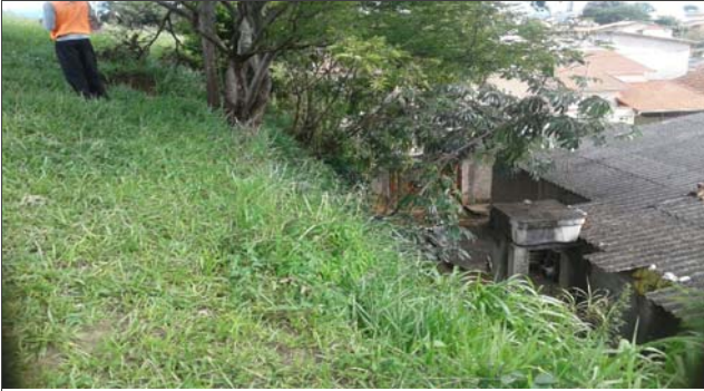
Foto: 1639417314585.jpg ID: 31 Visão geral do setor, Talude de corte com solo exposto
