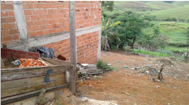
Foto: 1639658017610.jpg ID: 32 Talude natural
