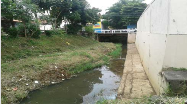
Foto: 1639483113301.jpg ID: 22 Visão geral da drenagem,
