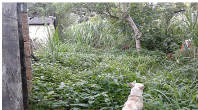
Foto: 1641234455487.jpg ID: 32 Moradia sujeita a risco de solapamento
