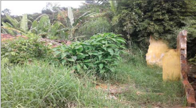
Foto: 1649251345224.jpg ID: 31 Moradia sujeita a risco de escorregamento
