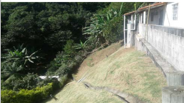
Foto: 1649334083090.jpg ID: 13 Detalhe para intervenção estrutural realizada para mitigação do risco
