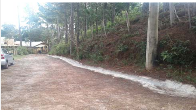
Foto: 1649335522967.jpg ID: 14 Detalhe para intervenção estrutural realizada para mitigação do risco, Formação de processo erosivo, Talude de corte com solo exposto
