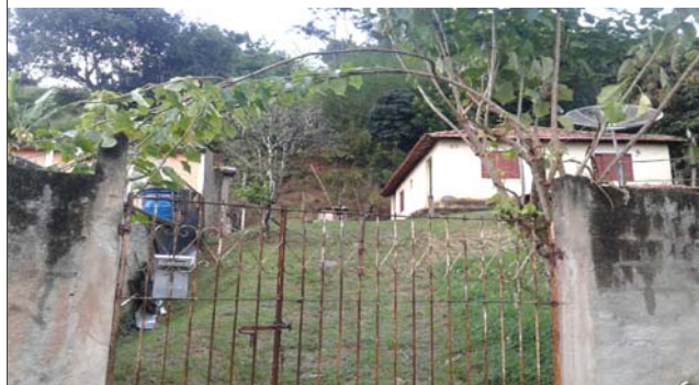
Foto: 1649183177535.jpg ID: 12 Depósito de escorregamento pretérito, Formação de processo erosivo, Moradia sujeita a risco de escorregamento, Talude de corte com solo exposto
