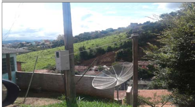
Foto: 1649337042678.jpg ID: 21 Visão geral do setor, Depósito de escorregamento pretérito, Presença de cicatriz de escorregamento pretérito
