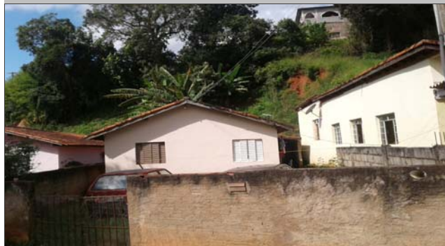
Foto: 1649265510112.jpg ID: 51 Formação de processo erosivo, Moradia sujeita a risco de escorregamento, Presença de cicatriz de escorregamento pretérito, Talude de corte com solo exposto
