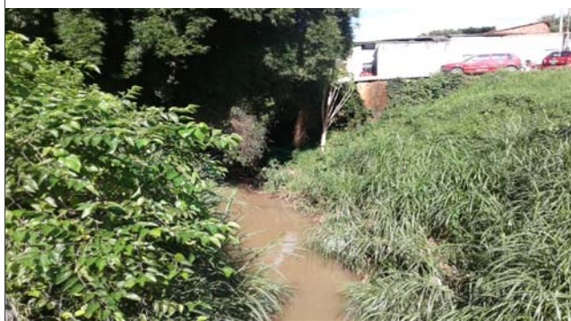
Foto: 1649095848863.jpg ID: 14 Detalhe do canal
