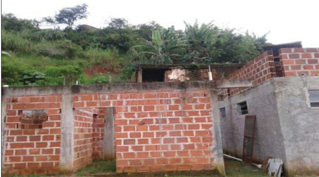
Foto: 1649251413646.jpg ID: 32 Formação de processo erosivo, Moradia sujeita a risco de escorregamento, Presença de cicatriz de escorregamento pretérito, Talude de corte com solo exposto
