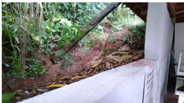
Foto: 1649183332696.jpg ID: 14 Detalhe para sistema de drenagem superficial, Detalhe para intervenção estrutural realizada para mitigação do risco
