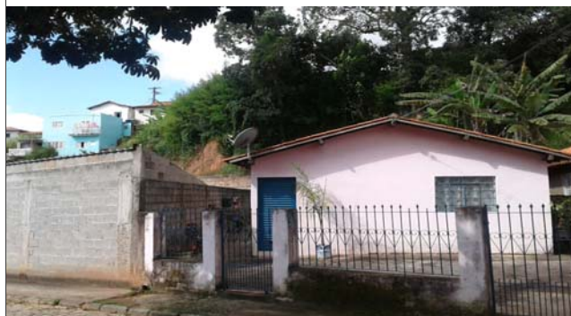
Foto: 1649265736230.jpg ID: 52 Formação de processo erosivo, Moradia sujeita a risco de escorregamento, Presença de cicatriz de escorregamento pretérito, Talude de corte com solo exposto
