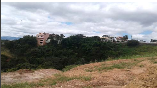
Foto: 1649345650073.jpg ID: 15 Visão geral do setor, Moradia sujeita a risco de escorregamento
