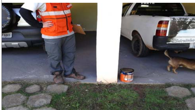
Foto: 1649095792878.jpg ID: 13 Detalhe para marca de água
