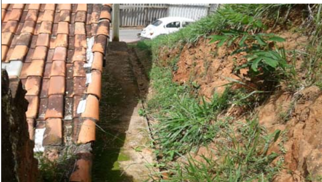
Foto: 1649342910043.jpg ID: 43 Detalhe para intervenção estrutural realizada para mitigação do risco, Formação de processo erosivo, Moradia sujeita a risco de escorregamento
