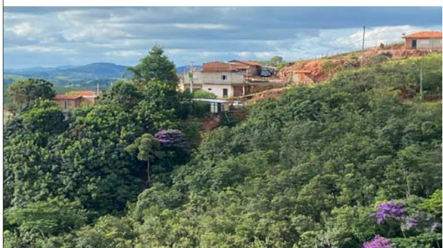
Foto: 1649364727438.jpg ID: 23 Visão geral do setor, Detalhe para processo de erosão, Detalhe para processo de ravinamento, Depósito de escorregamento pretérito, Presença de cicatriz de escorregamento pretérito, Formação de processo erosivo, Moradia sujeita a processos de erosão
