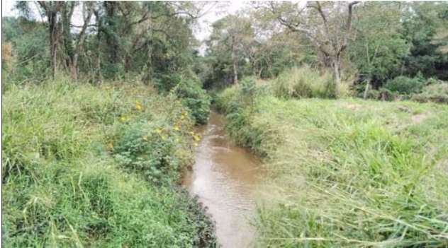
Foto: 1660053079229.jpg ID: 12 Detalhe do canal
