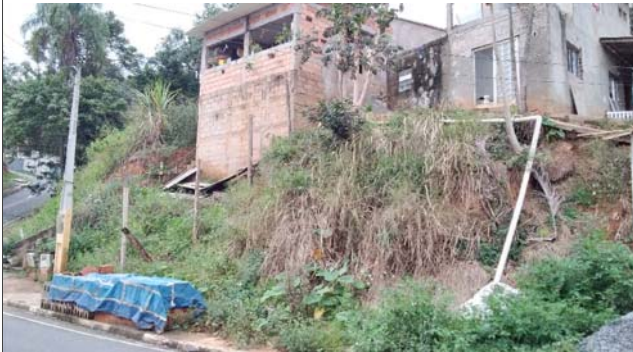
Foto: 1659989574155.jpg ID: 12 Moradia sujeita a risco de escorregamento, Talude de corte com solo exposto
