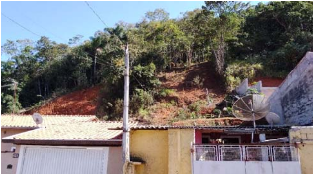
Foto: 1660571499566.jpg ID: 45 Moradia sujeita a risco de escorregamento, Talude de corte com solo exposto
