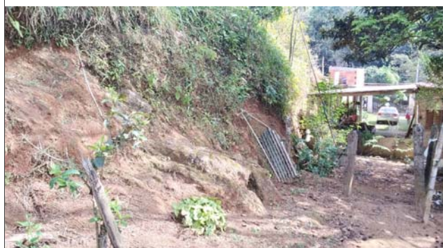
Foto: 1660661691908.jpg ID: 26 Talude de corte com afloramento de gnaiss milonitizado alterado
