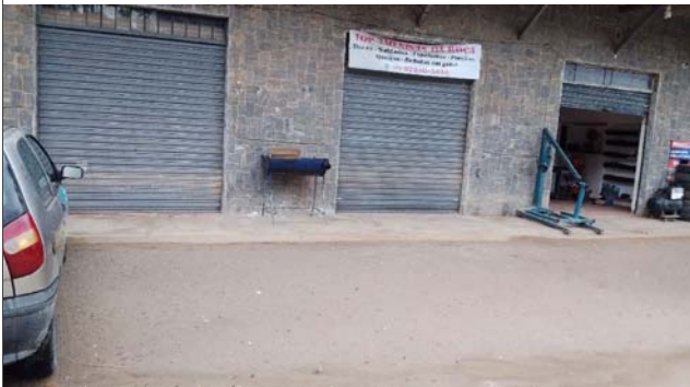
Foto: 1660134936711.jpg ID: 12 Detalhe para marca de água
