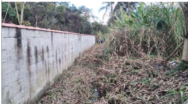
Foto: 1660152872640.jpg ID: 12 Detalhe do canal
