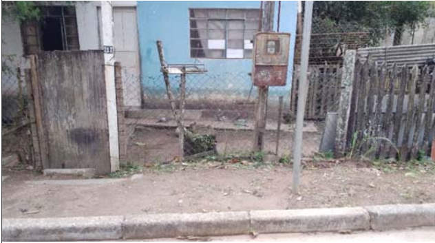
Foto: 1660242285236.jpg ID: 12 Detalhe para marca de água
