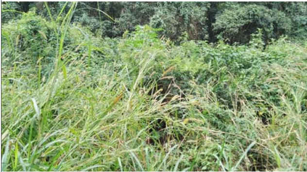
Foto: 1660068206478.jpg ID: 13 Detalhe do canal
