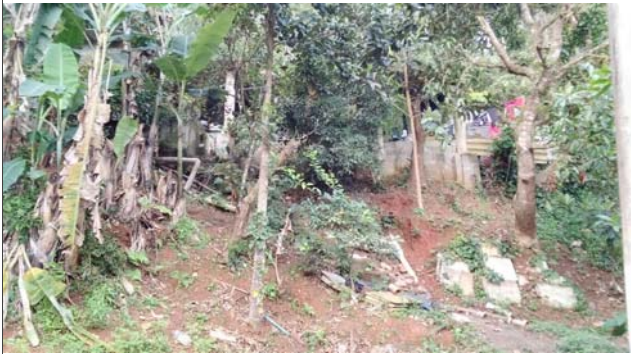
Foto: 1660564079868.jpg ID: 12 Moradia sujeita a risco de escorregamento
