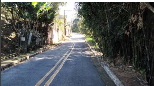
Foto: 1660568744622.jpg ID: 26 Evidência de movimentação no terreno
