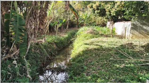
Foto: 1660242369416.jpg ID: 13 Detalhe do canal
