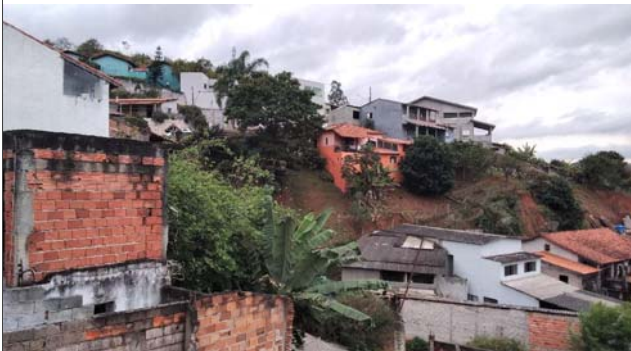
Foto: 1659987482720.jpg ID: 13 Visão geral do setor, Talude de corte com solo exposto
