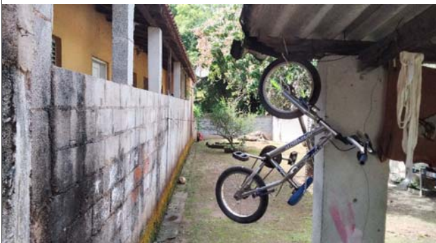
Foto: 1660226221469.jpg ID: 14 Detalhe para marca de água
