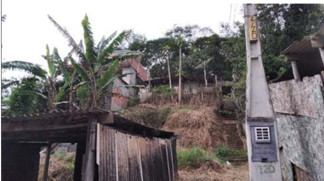
Foto: 1660059205684.jpg ID: 24 Moradia sujeita a risco de escorregamento, Talude de corte com solo exposto
