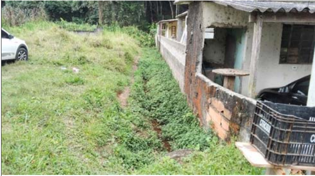
Foto: 1660058369217.jpg ID: 12 Visão geral da drenagem
