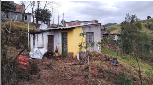
Foto: 1659973550011.jpg ID: 12 Visão geral do setor, Talude de corte com solo exposto
