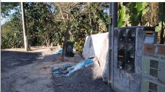
Foto: 1660591806393.jpg ID: 35 Evidência de movimentação em estruturas
