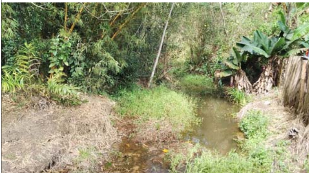
Foto: 1660234823323.jpg ID: 13 Detalhe do canal
