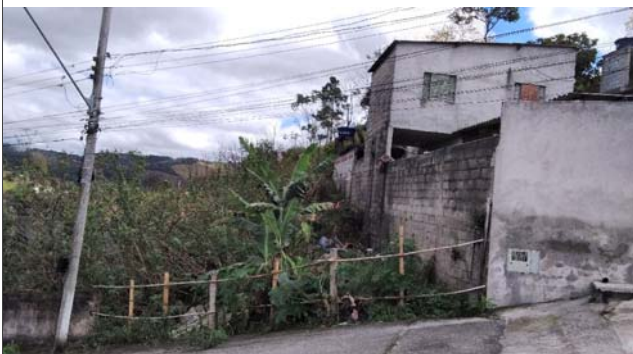
Foto: 1660314037620.jpg ID: 35 Moradia sujeita a risco de escorregamento
