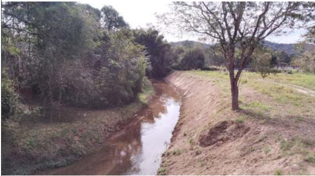
Foto: 1660677849350.jpg ID: 13 Detalhe do canal, detalhe para intervenções no canal
