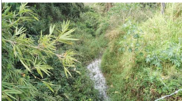
Foto: 1660137429184.jpg ID: 25 Detalhe do canal
