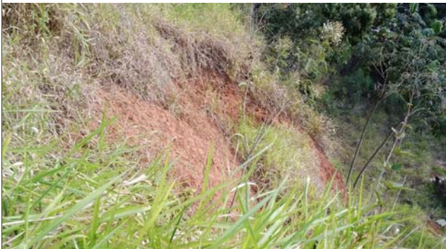
Foto: 1660564164515.jpg ID: 13 Depósito de escorregamento pretérito, Presença de cicatriz de escorregamento pretérito
