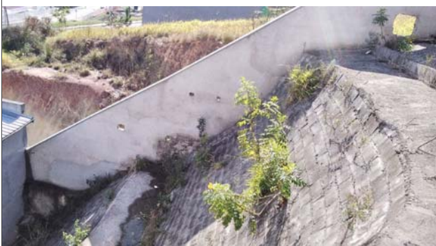
Foto: 1660308951567.jpg ID: 13 Detalhe para intervenção estrutural realizada para mitigação do risco
