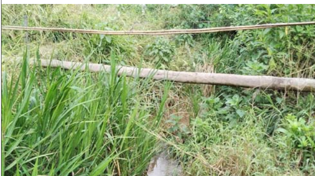
Foto: 1660226364715.jpg ID: 15 Detalhe do canal
