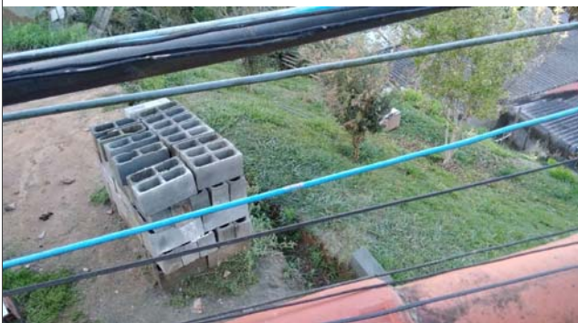
Foto: 1660161527179.jpg ID: 44 Evidência de movimentação no terreno
