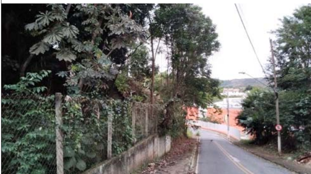
Foto: 1659990595014.jpg ID: 24 Presença de árvore inclinada
