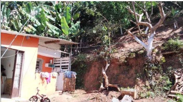
Foto: 1660584940263.jpg ID: 24 Moradia sujeita a risco de escorregamento, Talude de corte com solo exposto
