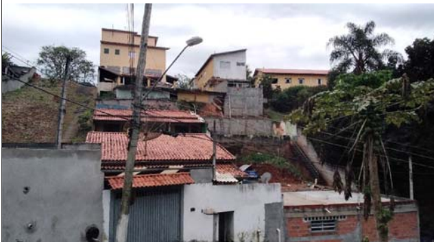
Foto: 1659990334429.jpg ID: 23 Depósito de escorregamento pretérito, Detalhe para intervenção estrutural realizada para mitigação do risco, Presença de cicatriz de escorregamento pretérito, Talude de corte com solo exposto
