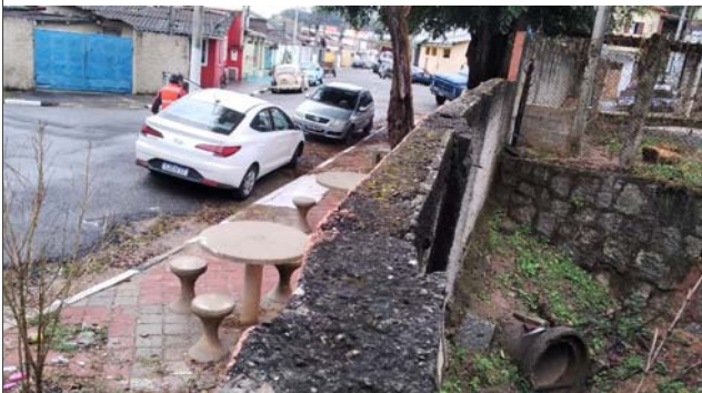
Foto: 1659966927601.jpg ID: 13 Detalhe do canal, detalhe para intervenções no canal
