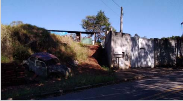
Foto: 1660567173118.jpg ID: 32 Talude de corte com solo exposto
