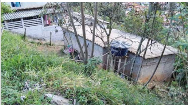
Foto: 1660564473859.jpg ID: 15 Moradia sujeita a risco de escorregamento
