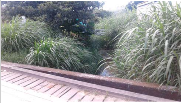
Foto: 1650982921955.jpg ID: 22 Visão geral da drenagem
