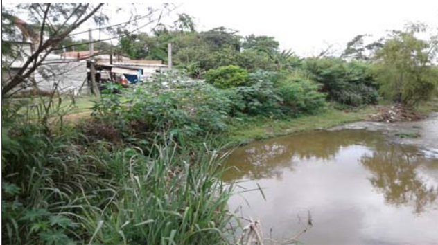
Foto: 1649950590882.jpg ID: 12 Visão geral da drenagem
