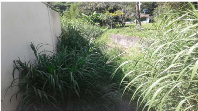
Foto: 1650984708983.jpg ID: 23 Visão geral da drenagem
