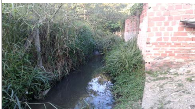
Foto: 1650398420321.jpg ID: 14 Detalhe do canal
