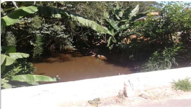
Foto: 1650990052981.jpg ID: 32 Visão geral da drenagem
