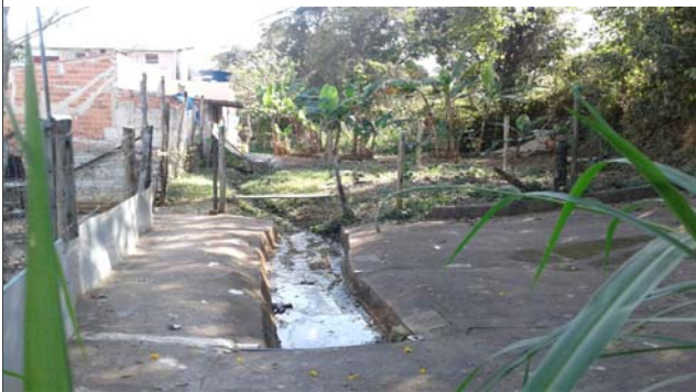
Foto: 1660854224250.jpg ID: 24 Detalhe do canal, detalhe para intervenções no canal
