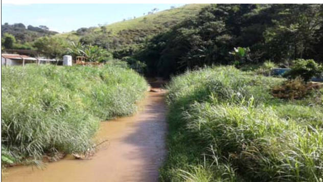
Foto: 1650372833589.jpg ID: 13 Visão geral da drenagem
