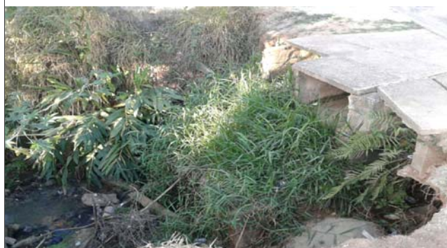
Foto: 1660851504039.jpg ID: 15 Presença de cicatriz de escorregamento pretérito, Lançamento de águas/esgoto na superfície
