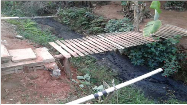
Foto: 1660853415048.jpg ID: 21 Detalhe do canal
