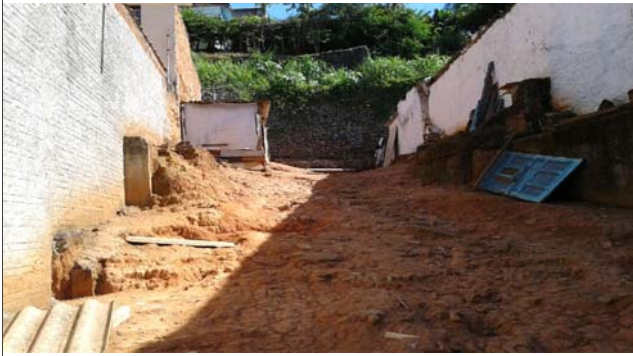
Foto: 1650304207750.jpg ID: 22 Depósito de escorregamento pretérito, Detalhe para intervenção estrutural realizada para mitigação do risco
