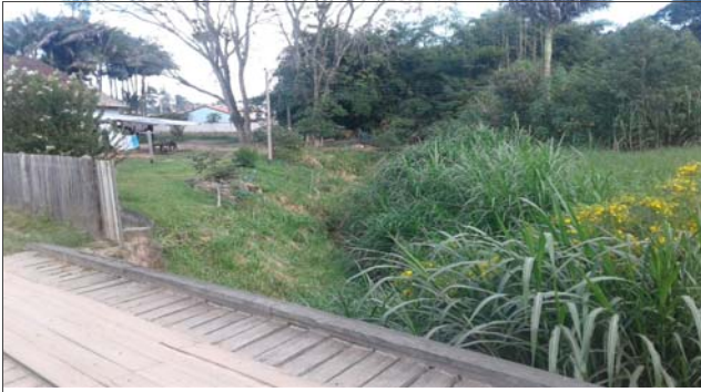
Foto: 1650982860434.jpg ID: 21 Visão geral da drenagem
