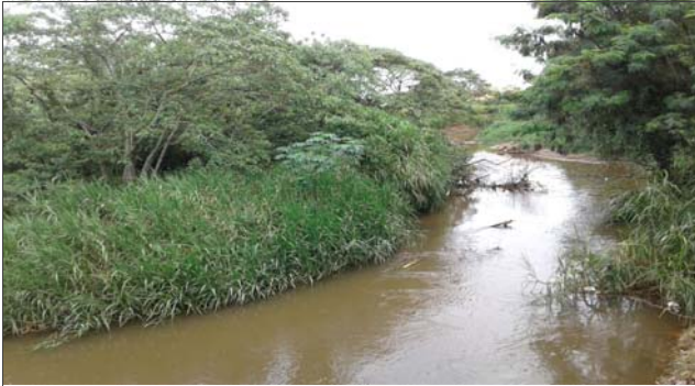
Foto: 1649950507990.jpg ID: 11 Visão geral da drenagem
