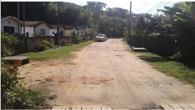
Foto: 1650995590854.jpg ID: 53 Imóveis afetados pelo processo
