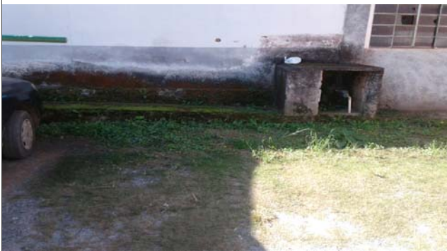
Foto: 1650995973197.jpg ID: 54 Detalhe para nível de atingimento
