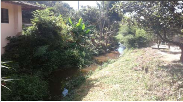
Foto: 1650989982836.jpg ID: 31 Visão geral da drenagem
