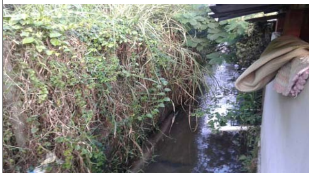
Foto: 1650397608396.jpg ID: 12 Visão geral da drenagem
