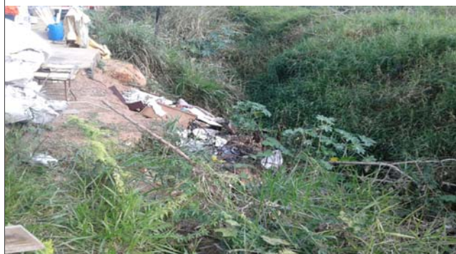
Foto: 1660850529842.jpg ID: 12 Detalhe para processo de solapamento no talude marginal, Presença de vazamento de tubulação de água/esgoto
