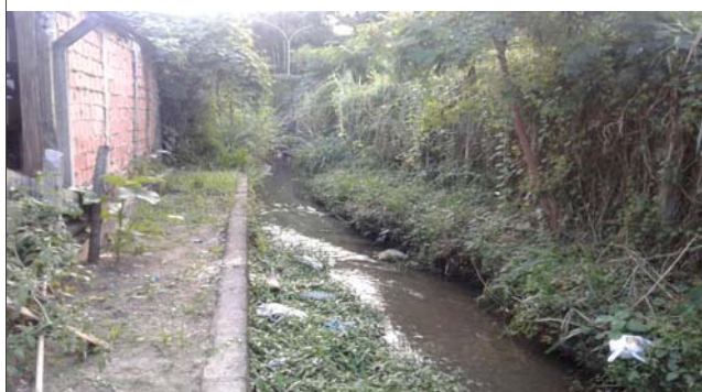
Foto: 1650398482685.jpg ID: 15 Detalhe do canal
