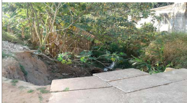
Foto: 1660851468153.jpg ID: 14 Presença de cicatriz de escorregamento pretérito, Lançamento de águas/esgoto na superfície
