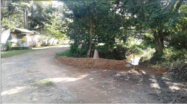
Foto: 1650392177197.jpg ID: 11 Visão geral da drenagem
