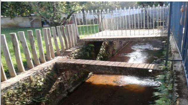
Foto: 1650392803616.jpg ID: 13 Detalhe do canal
