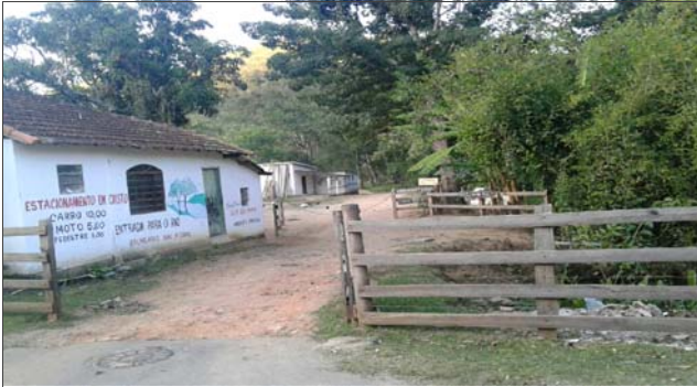
Foto: 1650916778864.jpg ID: 21 Visão geral da área, Limite da área atingida pelo processo, Imóveis afetados pelo processo, Detalhe do canal
