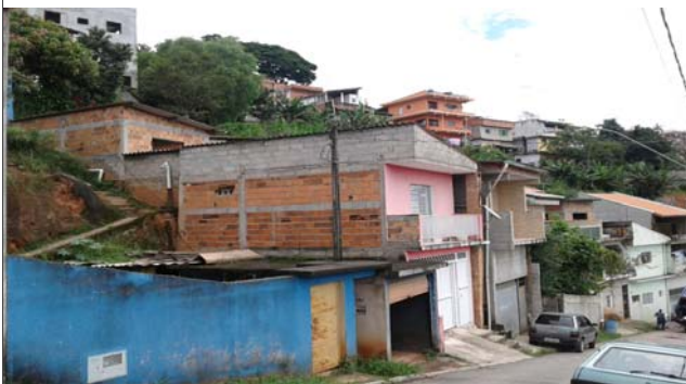
Foto: 1647618290579.jpg ID: 15 Visão geral do setor, Talude de corte com solo exposto
