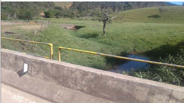
Foto: 1647954006577.jpg ID: 13 Visão geral da drenagem, Vista para montante
