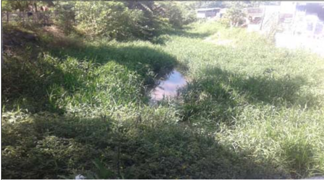
Foto: 1647953750160.jpg ID: 11 Visão geral da drenagem, Vista para jusante
