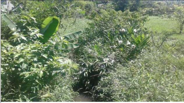
Foto: 1647960400242.jpg ID: 21 Visão geral da drenagem, Vista para jusante
