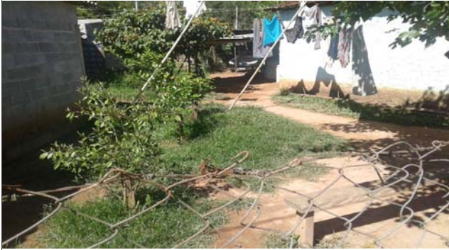
Foto: 1647970026802.jpg ID: 12 Detalhe para marca de água, 0,6 m
