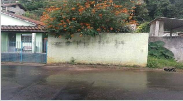
Foto: 1642614234086.jpg ID: 41 Visão geral do setor, Moradia sujeita a risco de escorregamento
