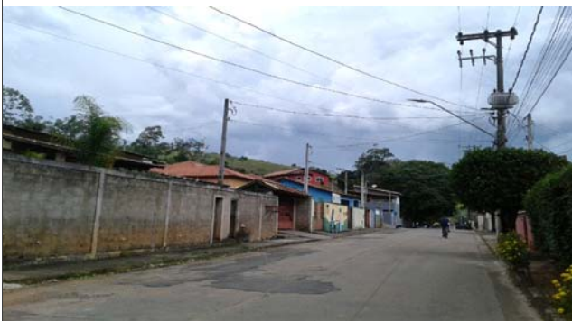
Foto: 1642612317866.jpg ID: 73 Moradia sujeita a risco de escorregamento
