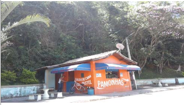
Foto: 1642606563376.jpg ID: 63 Moradia sujeita a risco de escorregamento Outras
