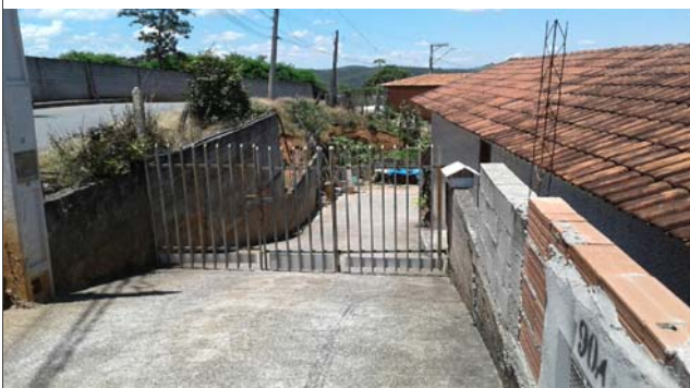
Foto: 1642600165152.jpg ID: 54 Detalhe para intervenção estrutural realizada para mitigação do risco, Talude de corte com solo exposto
