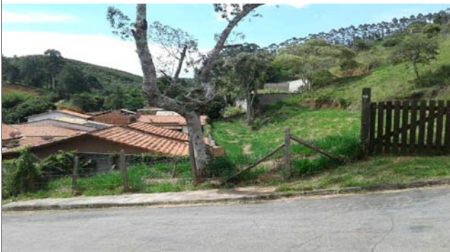
Foto: 1642610737804.jpg ID: 72 Moradia sujeita a risco de escorregamento, Talude natural
