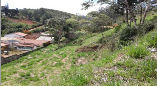
Foto: 1642610332182.jpg ID: 71 Visão geral do setor, Moradia sujeita a risco de escorregamento,
