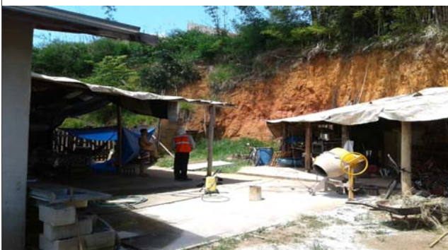
Foto: 1642595971913.jpg ID: 84 Moradia sujeita a risco de escorregamento, Talude de corte com solo exposto
