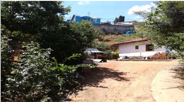
Foto: 1642595110493.jpg ID: 82 Moradia sujeita a risco de escorregamento, Talude de corte com solo exposto
