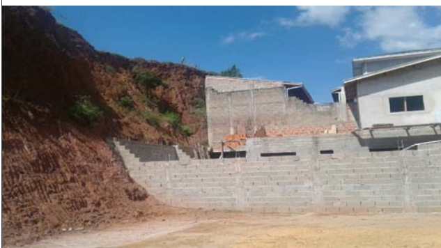
Foto: 1649690544586.jpg ID: 14 Visão geral do setor, Talude de corte com solo exposto
