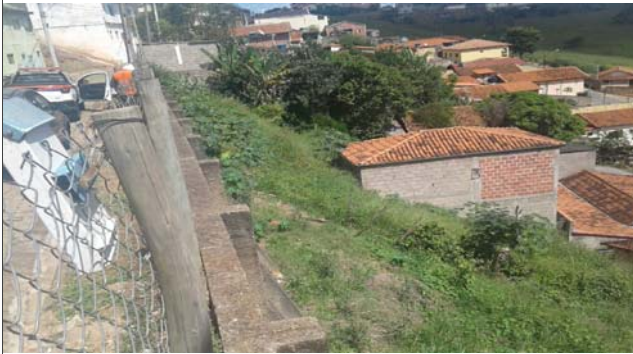
Foto: 1649692072451.jpg ID: 12 Visão geral do setor, Detalhe para intervenção estrutural realizada para mitigação do risco
