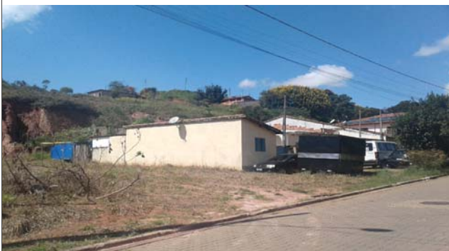
Foto: 1649690514011.jpg ID: 13 Visão geral do setor, Talude de corte com solo exposto
