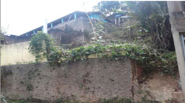
Foto: 1649686913874.jpg ID: 22 Visão geral do setor, Depósito de escorregamento pretérito
