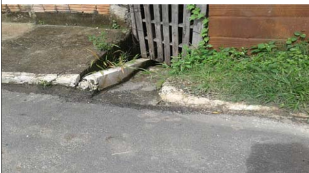
Foto: 1639049526070.jpg ID: 13 Detalhe da drenagem superficial
