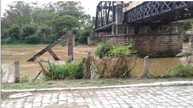
Foto: 1638960273301.jpg ID: 12 Visão geral da drenagem
