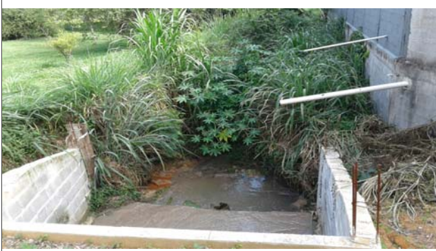
Foto: 1638810154614.jpg ID: 13 Visão geral da drenagem
