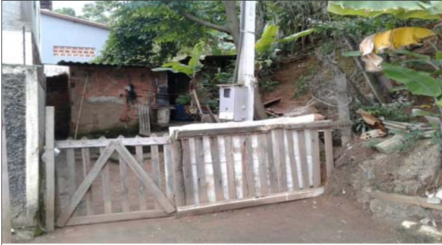
Foto: 1638817381360.jpg ID: 11 Formação de processo erosivo, Talude de corte com solo exposto
