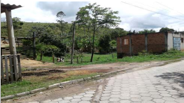
Foto: 1639052965217.jpg ID: 23 Visão geral da drenagem
