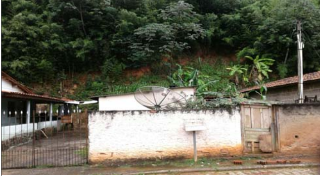
Foto: 1638894821470.jpg ID: 31 Moradia sujeita a risco de escorregamento, Presença de cicatriz de escorregamento pretérito, Talude de corte com solo exposto
