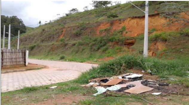
Foto: 1638884944912.jpg ID: 11 Formação de processo erosivo, Presença de cicatriz de escorregamento pretérito, Talude de corte com solo exposto
