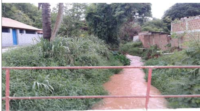
Foto: 1638901287780.jpg ID: 13 Visão geral da drenagem
