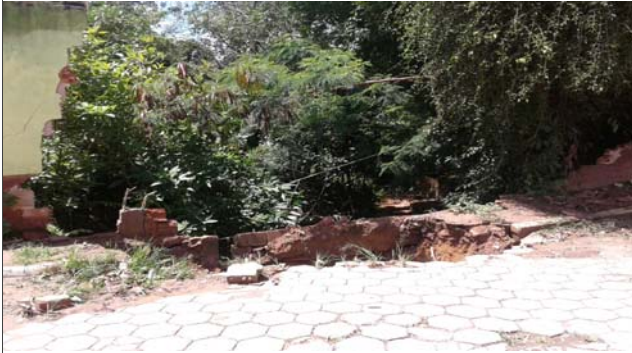
Foto: 1639052913563.jpg ID: 22 Visão geral da drenagem
