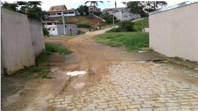
Foto: 1638878342439.jpg ID: 12 Imóveis afetados pelo processo, detalhe para intervenções no canal
