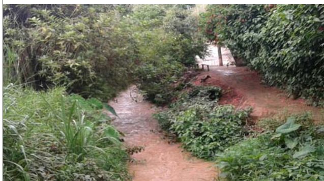
Foto: 1638900826877.jpg ID: 12 Detalhe do canal
