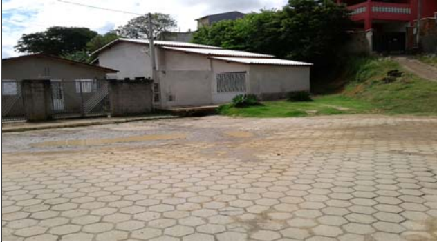
Foto: 1638878205312.jpg ID: 11 Imóveis afetados pelo processo, detalhe para intervenções no canal
