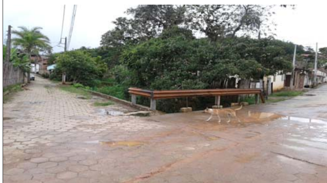
Foto: 1638902034965.jpg ID: 14 Visão geral da drenagem, Imóveis afetados pelo processo
