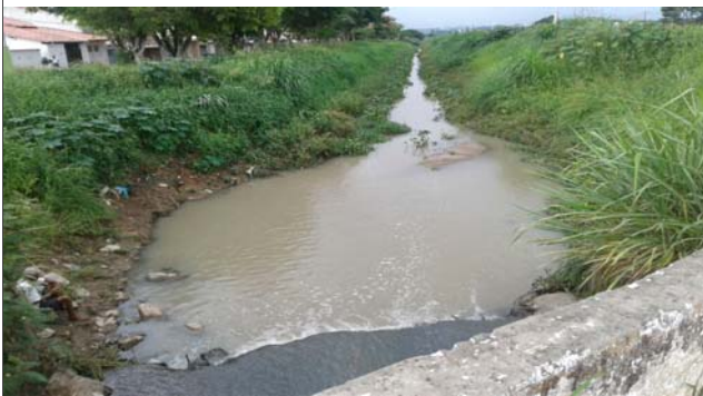
Foto: 1638293069059.jpg ID: 32 Visão geral da drenagem
