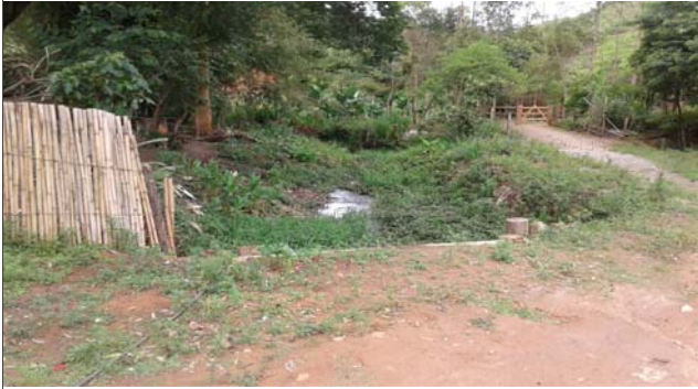
Foto: 1638272442198.jpg ID: 12 Visão geral da drenagem
