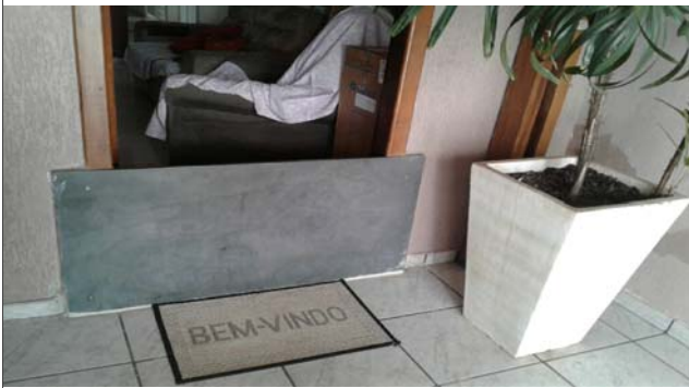
Foto: 1638462681527.jpg ID: 53 Detalhe para comporta
