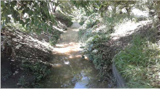
Foto: 1638359750857.jpg ID: 22 Visão geral da drenagem
