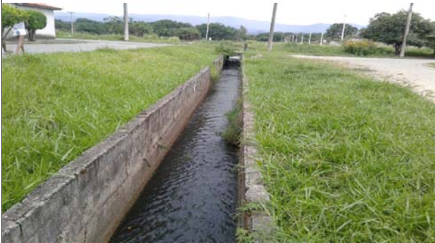
Foto: 1638472213549.jpg ID: 62 Visão geral da drenagem,
