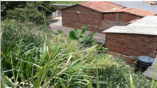
Foto: 1638540567560.jpg ID: 13 Moradia sujeita a risco de escorregamento
