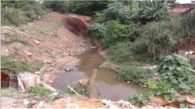
Foto: 1638534628797.jpg ID: 12 Detalhe do canal
