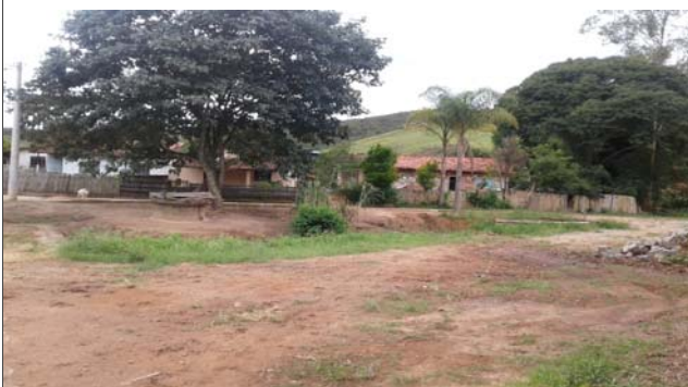
Foto: 1638272532917.jpg ID: 14 Imóveis afetados pelo processo
