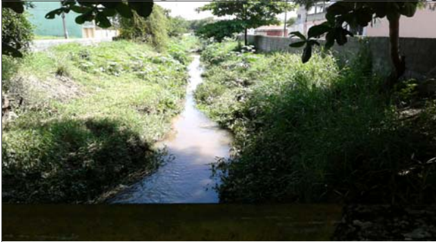
Foto: 1638359720963.jpg ID: 21 Visão geral da drenagem
