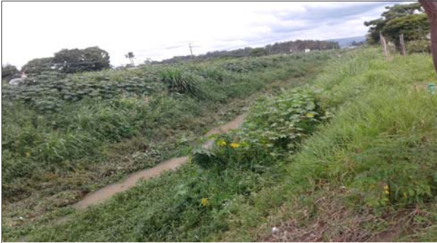
Foto: 1638291976143.jpg ID: 21 Visão geral da drenagem
