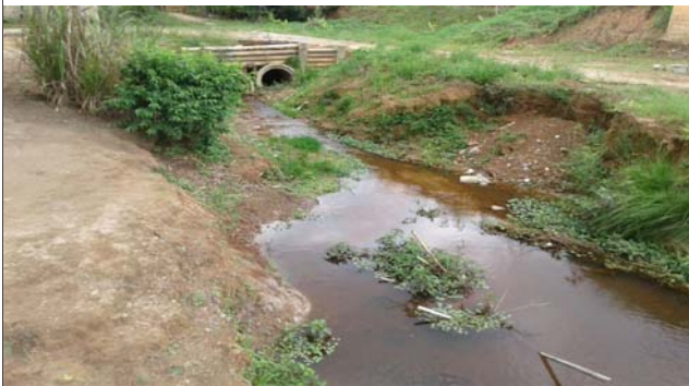
Foto: 1638272469122.jpg ID: 13 Visão geral da drenagem
