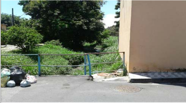
Foto: 1638365643837.jpg ID: 32 Visão geral da drenagem,
