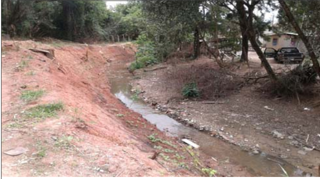
Foto: 1638534525720.jpg ID: 11 Visão geral da drenagem
