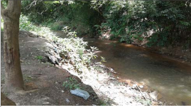
Foto: 1638450089014.jpg ID: 11 Visão geral da drenagem, Vista para jusante
