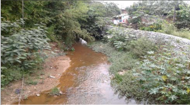
Foto: 1638531565458.jpg ID: 31 Detalhe do canal
