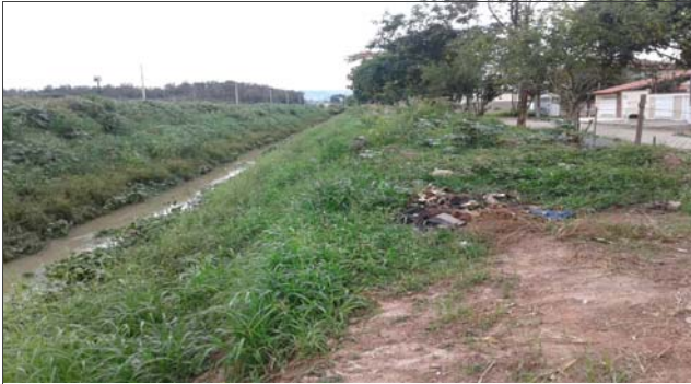
Foto: 1638292202677.jpg ID: 31 Visão geral da drenagem, Imóveis afetados pelo processo
