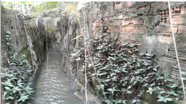
Foto: 1638463438710.jpg ID: 55 Detalhe do canal,
