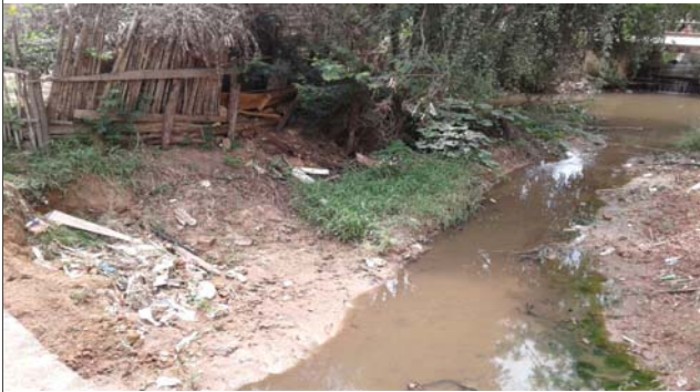
Foto: 1638534926826.jpg ID: 13 Detalhe do canal
