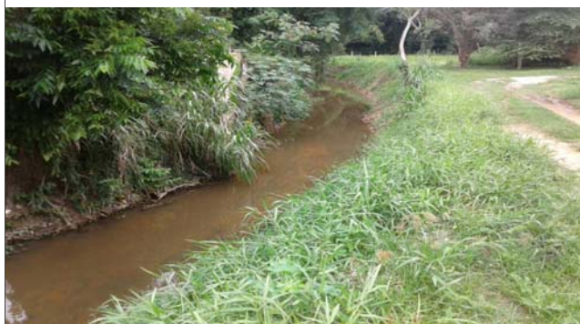
Foto: 1638529320735.jpg ID: 12 Visão geral da drenagem
