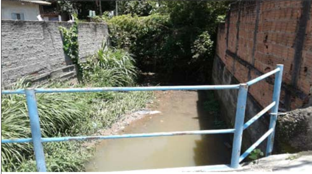
Foto: 1638365588208.jpg ID: 31 Visão geral da drenagem, Vista para jusante
