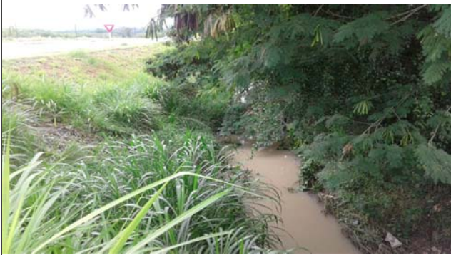
Foto: 1638288822376.jpg ID: 12 Visão geral da drenagem
