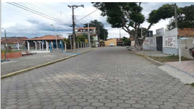
Foto: 1638292065719.jpg ID: 23 Imóveis afetados pelo processo
