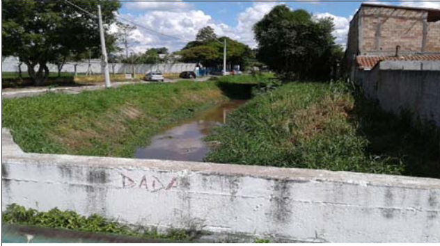
Foto: 1638376084763.jpg ID: 41 Visão geral da drenagem, Vista para montante
