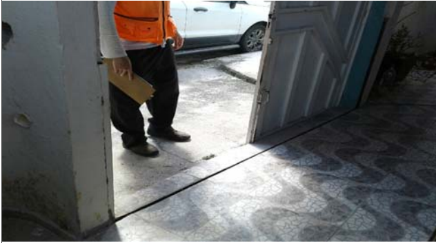
Foto: 1638376152932.jpg ID: 42 Detalhe para comporta
