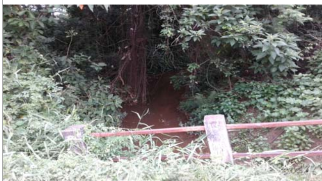
Foto: 1638529451832.jpg ID: 14 Visão geral da drenagem
