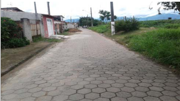
Foto: 1638292032068.jpg ID: 22 Imóveis afetados pelo processo
