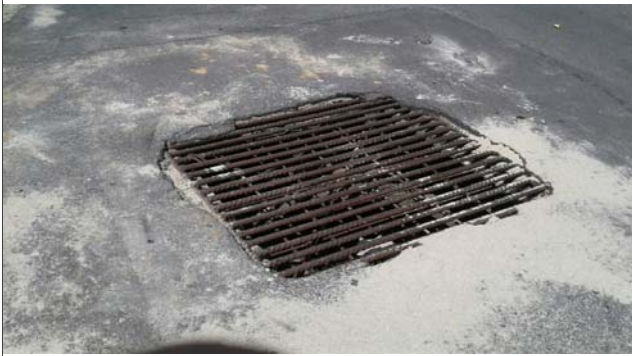
Foto: 1638459499326.jpg ID: 52 detalhe para intervenções no canal,
