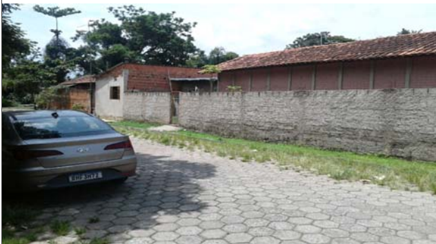
Foto: 1638450221961.jpg ID: 13 Visão geral da drenagem, Imóveis afetados pelo processo
