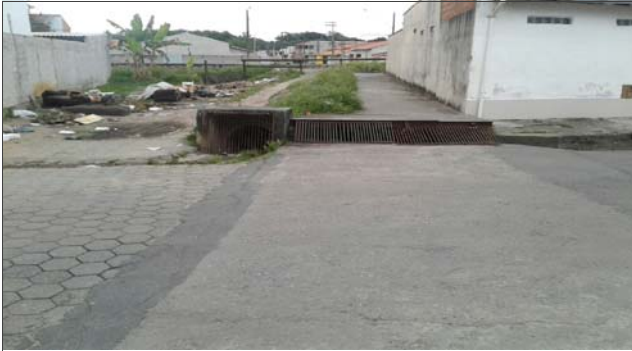
Foto: 1638472149251.jpg ID: 61 Detalhe do canal, Drenagem superficial e drenagem canalizada
