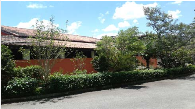
Foto: 1642774321181.jpg ID: 12 Moradia sujeita a risco de escorregamento
