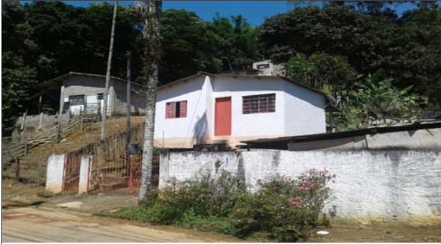
Foto: 1642768116363.jpg ID: 11 Visão geral do setor, Detalhe para intervenção estrutural realizada para mitigação do risco, Moradia sujeita a risco de escorregamento,
