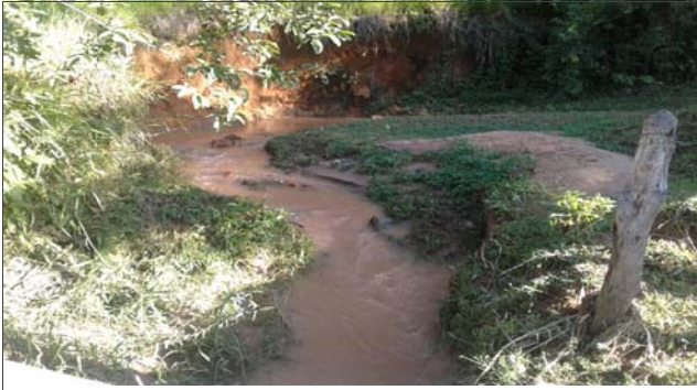
Foto: 1642706682881.jpg ID: 31 Visão geral da drenagem, Vista para montante
