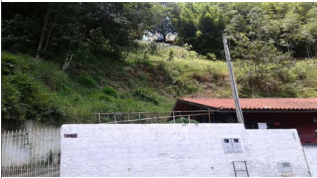
Foto: 1642771775951.jpg ID: 33 Formação de processo erosivo
