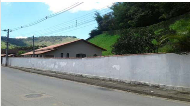
Foto: 1642771285075.jpg ID: 53 Talude de corte
