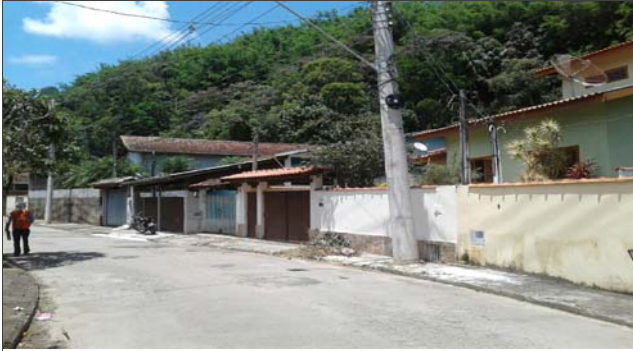
Foto: 1642771532276.jpg ID: 31 Visão geral do setor, Moradia sujeita a risco de escorregamento
