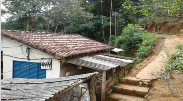
Foto: 1643370259157.jpg ID: 12 Talude de corte com solo exposto
