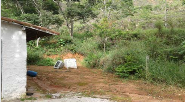
Foto: 1643365189345.jpg ID: 12 Visão geral do setor, Depósito de escorregamento pretérito, Moradia sujeita a risco de escorregamento
