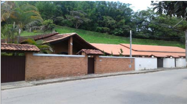
Foto: 1642771187280.jpg ID: 52 Visão geral do setor, Moradia sujeita a risco de escorregamento
