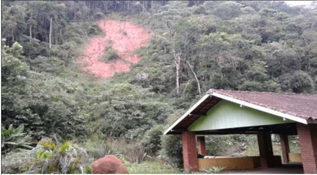
Foto: 1643217545645.jpg ID: 21 Formação de processo erosivo, Presença de cicatriz de escorregamento pretérito
