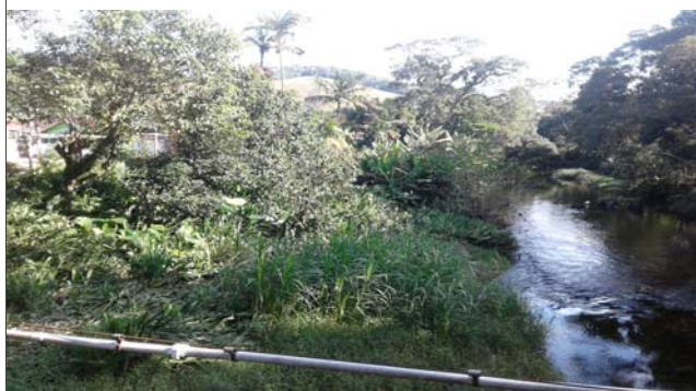
Foto: 1654623130337.jpg ID: 13 Visão geral da drenagem
