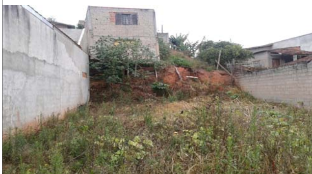
Foto: 1654786633856.jpg ID: 12 Formação de processo erosivo, Moradia sujeita a risco de escorregamento, Presença de cicatriz de escorregamento pretérito, Talude de corte com solo exposto
