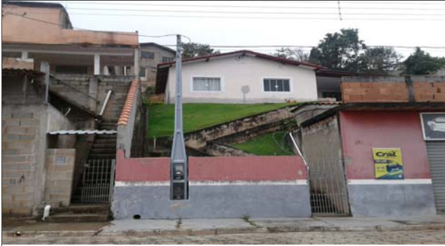
Foto: 1654783609631.jpg ID: 21 Visão geral do setor, Talude de corte com solo exposto
