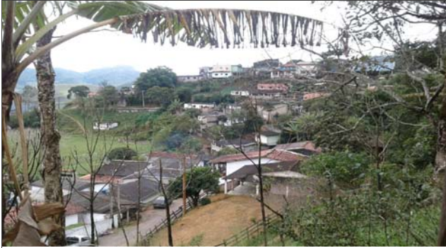
Foto: 1654697914190.jpg ID: 11 Visão geral do setor, Moradia sujeita a risco de escorregamento
