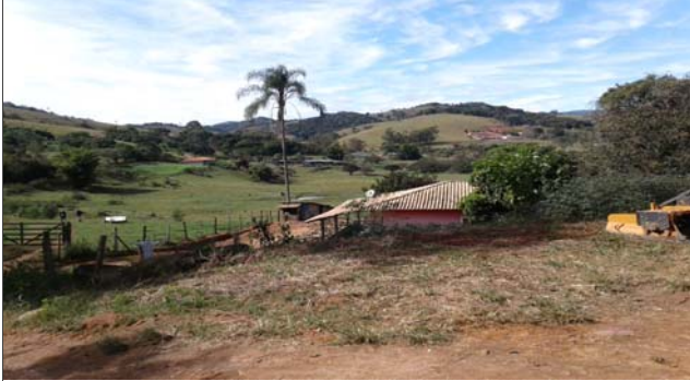
Foto: 1655130306103.jpg ID: 11 Visão geral da drenagem, Imóveis afetados pelo processo
