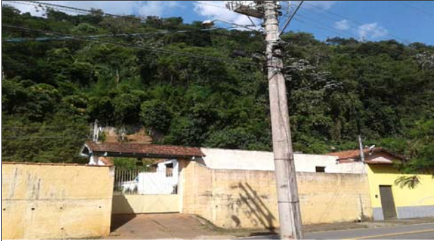
Foto: 1646677926699.jpg ID: 31 Visão geral do setor, Moradia sujeita a risco de escorregamento,
