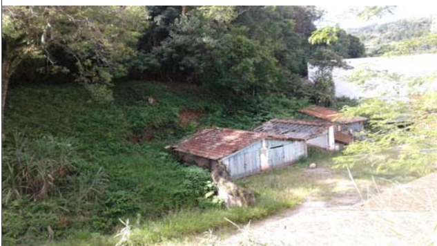
Foto: 1647541831732.jpg ID: 34 Formação de processo erosivo, Moradia sujeita a risco de escorregamento, Presença de cicatriz de escorregamento pretérito, Talude de corte com solo exposto
