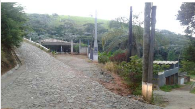
Foto: 1646944008388.jpg ID: 64 Visão geral do setor, Moradia sujeita a risco de escorregamento
