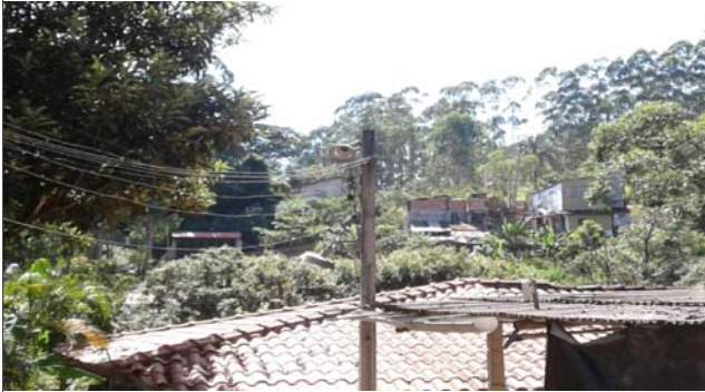
Foto: 1646658451669.jpg ID: 12 Visão geral do setor, Moradia sujeita a risco de escorregamento
