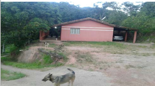
Foto: 1646943657646.jpg ID: 63 Moradia sujeita a risco de escorregamento, Talude de corte com solo exposto
