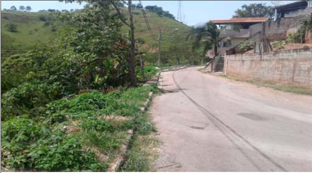
Foto: 1645711923538.jpg ID: 31 Evidência de movimentação no terreno
