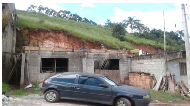
Foto: 1647350491423.jpg ID: 23 Formação de processo erosivo, Talude de corte com solo exposto
