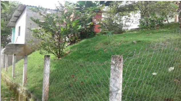
Foto: 1647001872200.jpg ID: 22 Visão geral do setor, Moradia sujeita a risco de escorregamento
