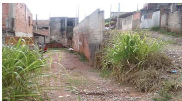
Foto: 1647350398938.jpg ID: 22 Evidência de movimentação em estruturas
