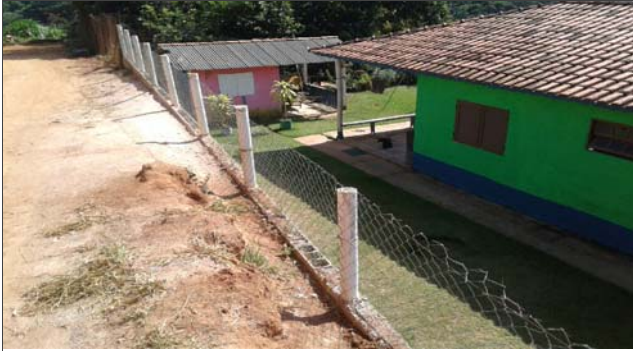
Foto: 1646744141358.jpg ID: 21 Detalhe para intervenção estrutural realizada para mitigação do risco,
