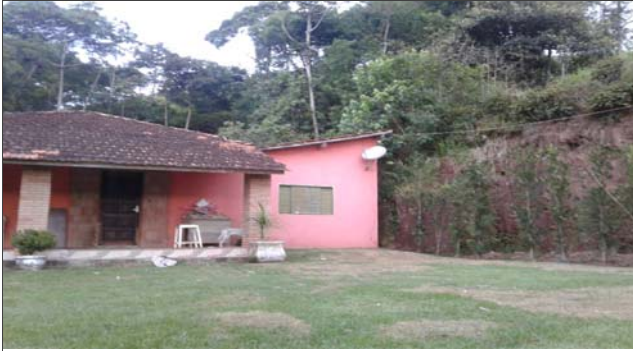
Foto: 1646943042552.jpg ID: 61 Talude de corte com solo exposto
