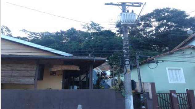
Foto: 1645643271618.jpg ID: 24 Talude de corte com solo exposto
