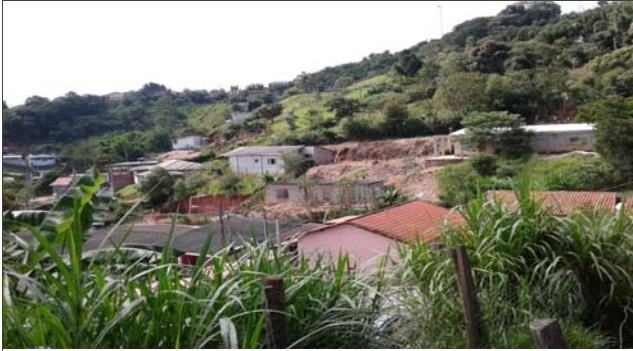
Foto: 1647263631216.jpg ID: 21 Visão geral do setor, Talude de corte com solo exposto
