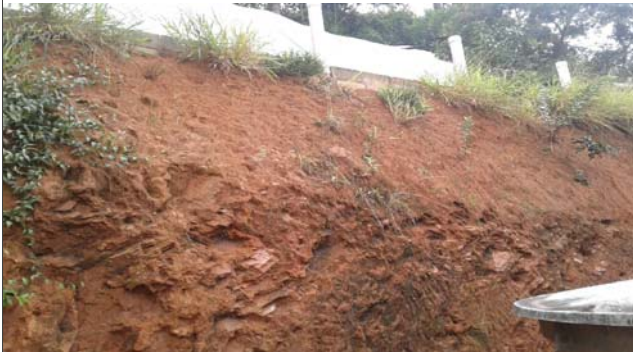
Foto: 1647007036746.jpg ID: 52 Talude de corte com solo exposto, Presença de berma
