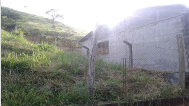
Foto: 1646941257382.jpg ID: 44 Visão geral do setor, Moradia sujeita a risco de escorregamento, Talude de corte com solo exposto
