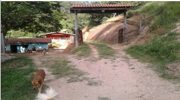
Foto: 1646940132466.jpg ID: 43 Moradia sujeita a risco de escorregamento, Talude de corte com solo exposto
