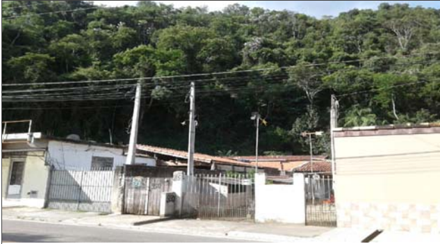
Foto: 1646678969867.jpg ID: 41 Depósito de escorregamento pretérito, Presença de cicatriz de escorregamento pretérito
