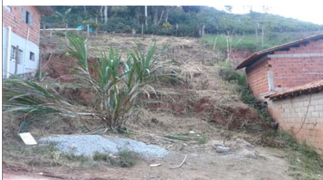
Foto: 1646768415465.jpg ID: 13 Moradia sujeita a risco de escorregamento, Presença de cicatriz de escorregamento pretérito, Talude de corte com solo exposto
