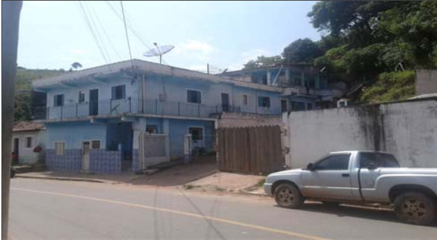
Foto: 1645709022705.jpg ID: 21 Visão geral do setor, Talude de corte com solo exposto
