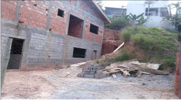
Foto: 1645641398065.jpg ID: 21 Presença de árvore inclinada, Talude de corte com solo exposto
