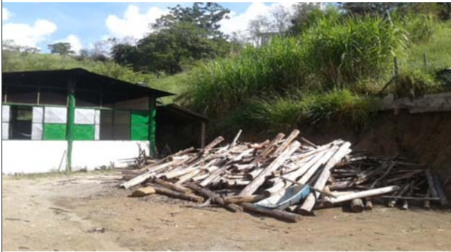
Foto: 1646763178819.jpg ID: 12 Talude de corte com solo exposto
