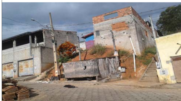
Foto: 1655229835516.jpg ID: 34 Formação de processo erosivo, Lançamento de águas/esgoto na superfície, Moradia sujeita a risco de escorregamento, Talude de corte com solo exposto
