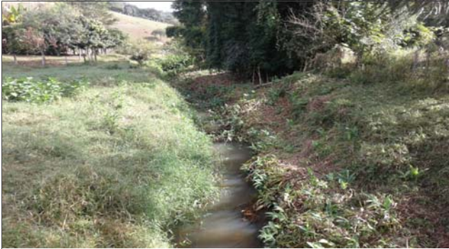
Foto: 1655125861219.jpg ID: 11 Detalhe do canal
