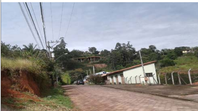
Foto: 1654869106584.jpg ID: 15 Evidência de movimentação no terreno, Formação de processo erosivo
