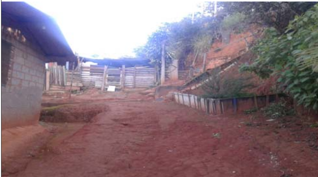
Foto: 1655143529541.jpg ID: 12 Formação de processo erosivo, Moradia sujeita a risco de escorregamento, Talude de corte com solo exposto
