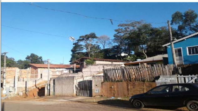
Foto: 1655233339801.jpg ID: 43 Formação de processo erosivo, Talude de corte com solo exposto
