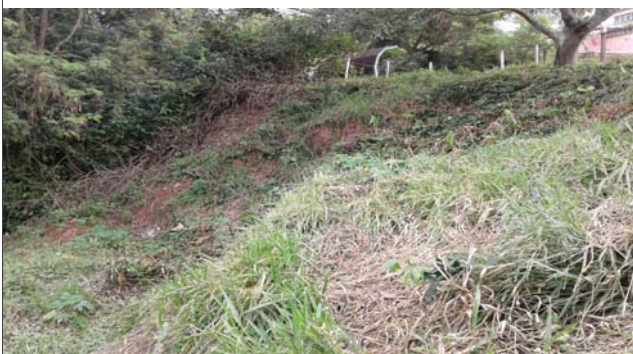
Foto: 1654799503702.jpg ID: 14 Formação de processo erosivo, Moradia sujeita a risco de escorregamento, Presença de cicatriz de escorregamento pretérito, Talude de corte com solo exposto
