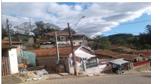
Foto: 1655229725647.jpg ID: 33 Formação de processo erosivo, Lançamento de águas/esgoto na superfície, Moradia sujeita a risco de escorregamento, Talude de corte com solo exposto
