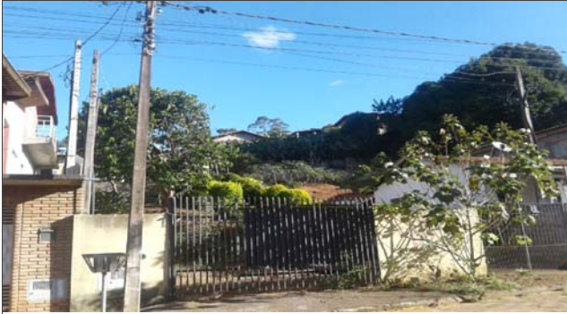
Foto: 1655231097970.jpg ID: 41 Formação de processo erosivo
