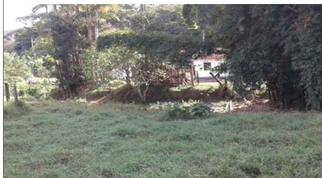
Foto: 1655127133099.jpg ID: 24 Visão geral do setor, Detalhe para processo de solapamento no talude marginal, Presença de cicatriz de escorregamento pretérito, Formação de processo erosivo, Moradia sujeita a risco de solapamento
