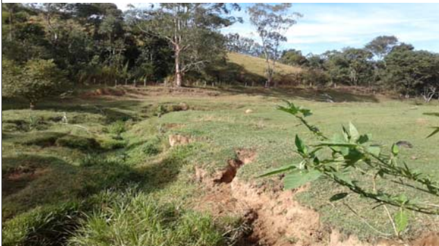
Foto: 1655125925103.jpg ID: 12 Detalhe do canal
