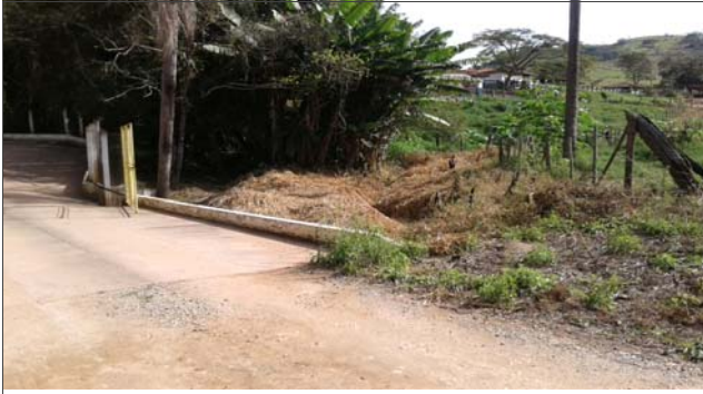
Foto: 1655134835920.jpg ID: 11 Detalhe do canal
