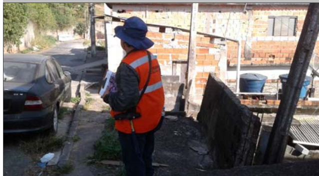
Foto: 1658243768266.jpg ID: 11 Evidência de movimentação em estruturas, Evidência de movimentação no terreno, Presença de árvore inclinada
