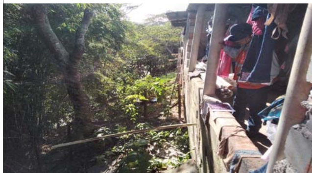
Foto: 1658325614394.jpg ID: 12 Lançamento de águas/esgoto na superfície, Moradia sujeita a risco de escorregamento
