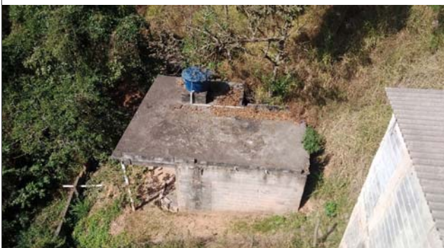
Foto: 1658947918063.jpg ID: 15 Moradia sujeita a risco de escorregamento, Talude de corte com solo exposto
