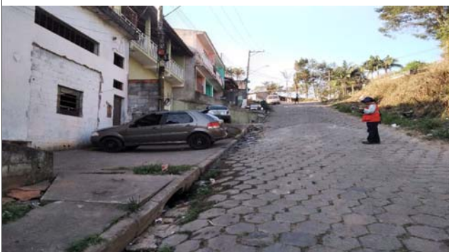
Foto: 1658860414590.jpg ID: 14 Lançamento de águas/esgoto na superfície
