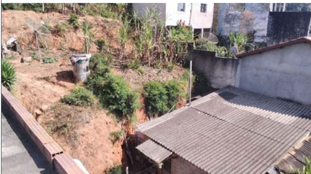
Foto: 1658947843333.jpg ID: 14 Moradia sujeita a risco de escorregamento, Talude de corte com solo exposto
