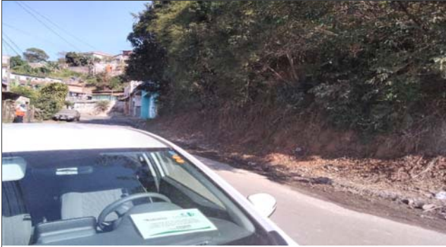
Foto: 1658848021103.jpg ID: 22 Talude de corte com solo exposto
