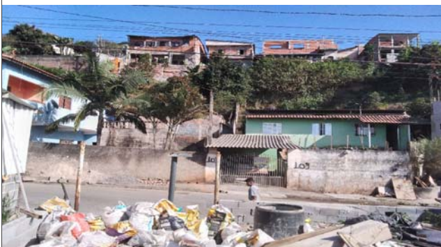
Foto: 1658848144377.jpg ID: 24 Moradia sujeita a risco de escorregamento
