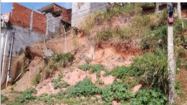
Foto: 1659022209596.jpg ID: 35 Depósito de escorregamento pretérito, Formação de processo erosivo, Lançamento de águas/esgoto na superfície, Moradia sujeita a risco de escorregamento, Presença de cicatriz de escorregamento pretérito, Talude de corte com solo exposto
