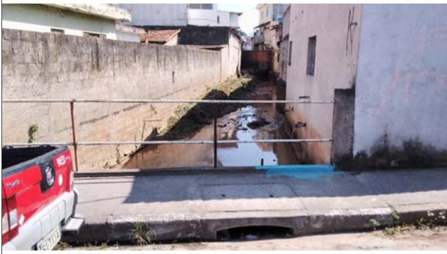
Foto: 1659448584230.jpg ID: 24 Detalhe do canal
