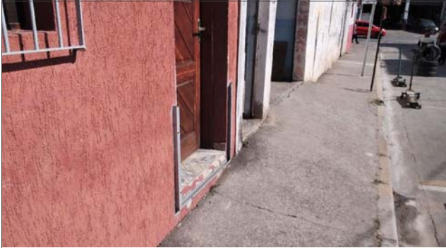
Foto: 1659447939763.jpg ID: 22 Detalhe para comporta
