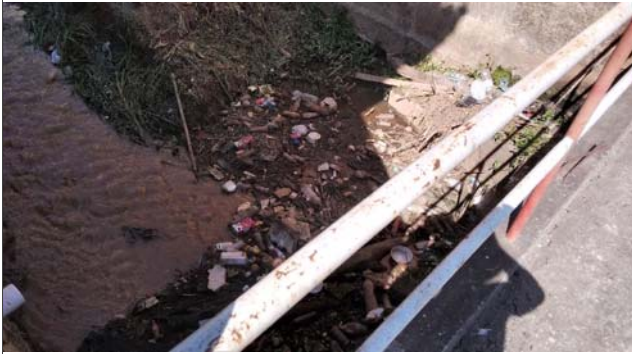
Foto: 1659449362458.jpg ID: 25 Detalhe do canal
