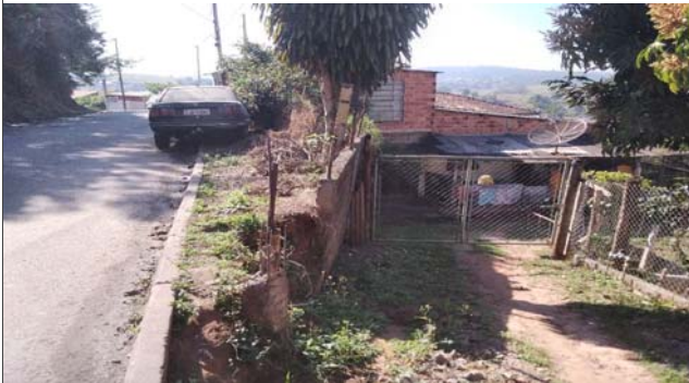
Foto: 1658848081477.jpg ID: 23 Evidência de movimentação em estruturas
