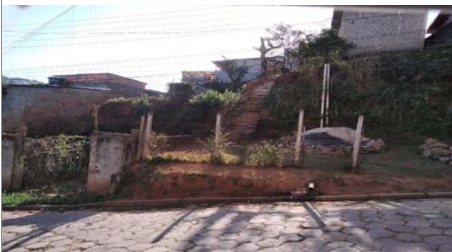
Foto: 1658859975229.jpg ID: 13 Moradia sujeita a risco de escorregamento, Talude de corte com solo exposto
