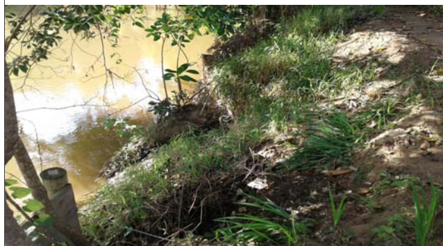
Foto: 1654105031798.jpg ID: 13 Detalhe para processo de solapamento no talude
