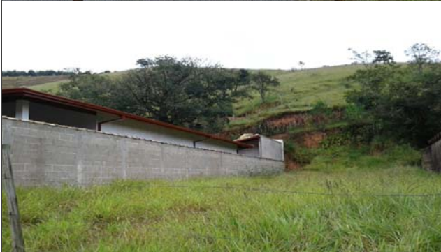
Foto: 1654002520684.jpg ID: 14 Depósito de escorregamento pretérito, Evidência de movimentação no terreno, Formação de processo erosivo, Moradia sujeita a risco de escorregamento, Presença de cicatriz de escorregamento pretérito, Talude de corte com solo exposto
