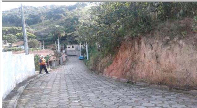
Foto: 1654191013867.jpg ID: 11 Visão geral do setor, Evidência de movimentação no terreno, Formação de processo erosivo, Presença de cicatriz de escorregamento pretérito, Talude de corte com solo exposto
