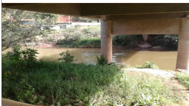
Foto: 1654609126731.jpg ID: 65 Detalhe do canal
