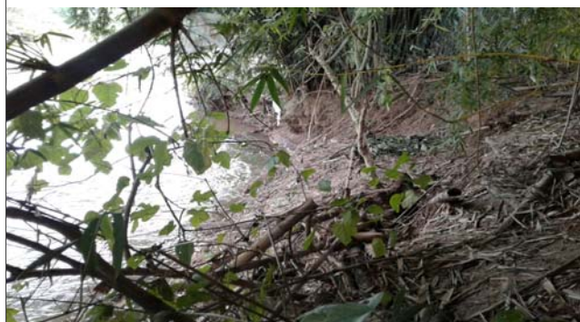
Foto: 1654107018811.jpg ID: 14 Detalhe do canal, Detalhe para processo de solapamento no talude
