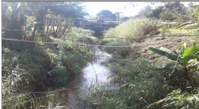
Foto: 1654172958654.jpg ID: 11 Visão geral da drenagem, Detalhe do canal
