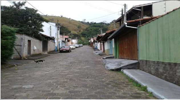
Foto: 1654001703440.jpg ID: 11 Visão geral do setor, Moradia sujeita a risco de escorregamento
