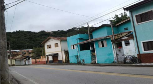
Foto: 1654007268224.jpg ID: 51 Visão geral do setor, Moradia sujeita a risco de escorregamento
