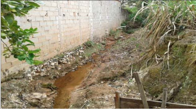
Foto: 1654261506072.jpg ID: 11 Detalhe do canal
