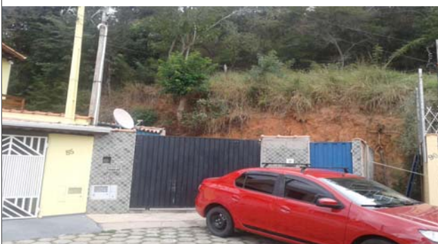
Foto: 1653929929511.jpg ID: 25 Formação de processo erosivo, Moradia sujeita a risco de escorregamento, Presença de cicatriz de escorregamento pretérito, Talude de corte com solo exposto
