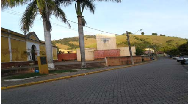
Foto: 1654545119896.jpg ID: 42 Limite da área atingida pelo processo, Imóveis afetados pelo processo
