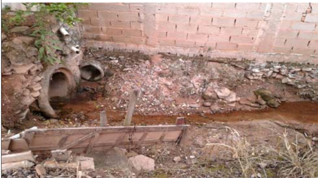
Foto: 1654261732107.jpg ID: 13 Detalhe do canal
