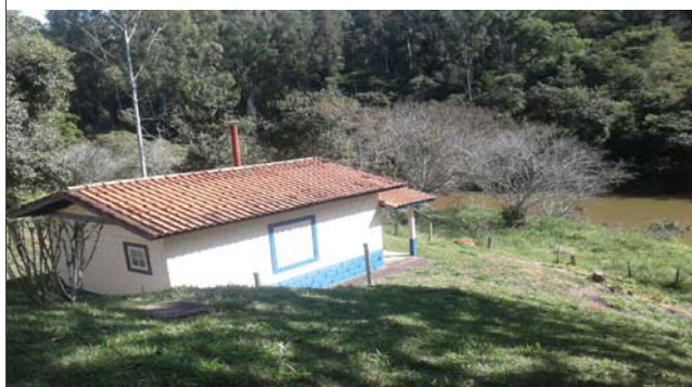
Foto: 1654526266580.jpg ID: 14 Limite da área atingida pelo processo, Imóveis afetados pelo processo, Detalhe do canal
