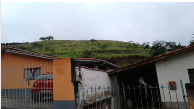
Foto: 1654001897073.jpg ID: 12 Depósito de escorregamento pretérito, Evidência de movimentação no terreno, Formação de processo erosivo, Moradia sujeita a risco de escorregamento, Presença de cicatriz de escorregamento pretérito, Talude de corte com solo exposto
