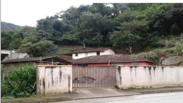
Foto: 1654094768614.jpg ID: 14 Formação de processo erosivo, Moradia sujeita a risco de escorregamento, Presença de cicatriz de escorregamento pretérito, Talude de corte com solo exposto
