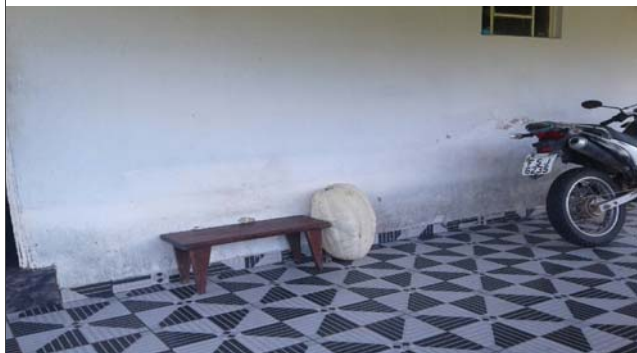
Foto: 1654173574952.jpg ID: 14 Imóveis afetados pelo processo, Detalhe para marca de água
