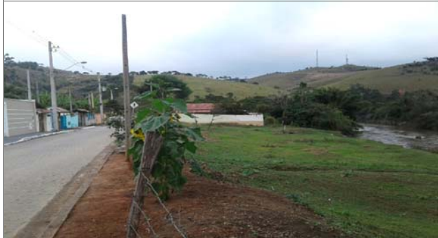
Foto: 1654523581715.jpg ID: 11 Visão geral da área, Imóveis afetados pelo processo, Detalhe do canal, Detalhe para marca de água
