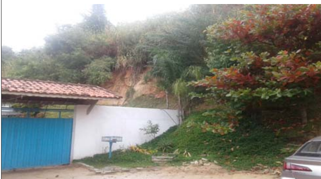
Foto: 1653924440453.jpg ID: 24 Formação de processo erosivo, Presença de cicatriz de escorregamento pretérito, Talude de corte com solo exposto
