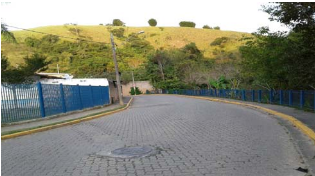
Foto: 1654545678110.jpg ID: 43 Limite da área atingida pelo processo, Imóveis afetados pelo processo
