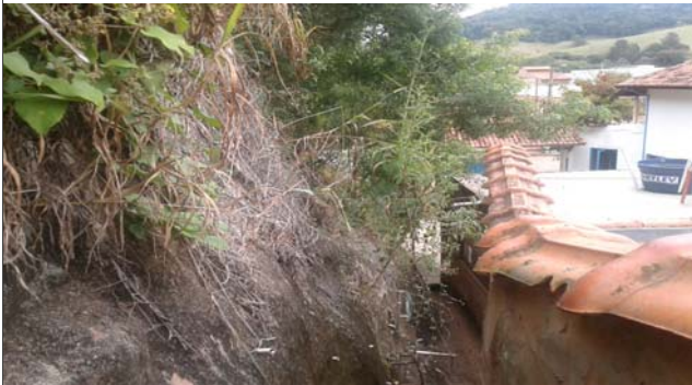
Foto: 1653923970841.jpg ID: 22 Visão geral do setor, Detalhe para intervenção estrutural realizada para mitigação do risco
