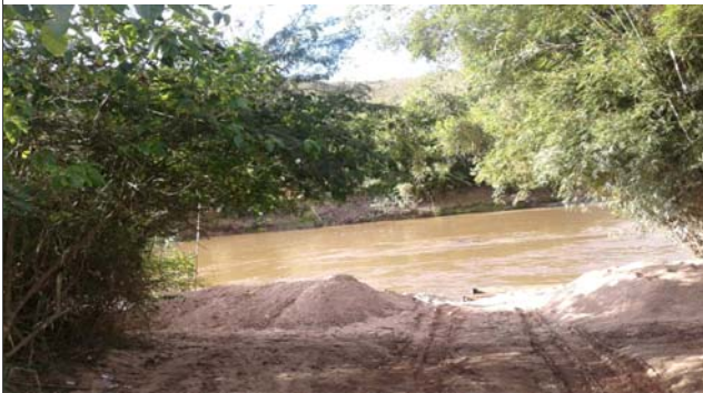
Foto: 1654536982399.jpg ID: 22 Visão geral da drenagem, Detalhe do canal
