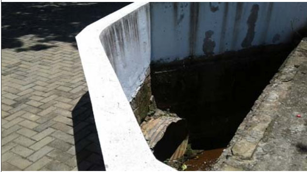
Foto: 1636030398930.jpg ID: 22 detalhe para intervenções no canal
