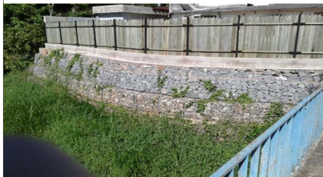
Foto: 1636025419538.jpg ID: 13 Detalhe para intervenções no canal
