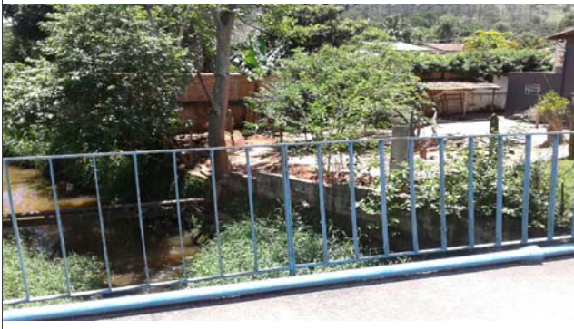
Foto: 1636031239064.jpg ID: 24 Visão geral da drenagem, Imóveis afetados pelo processo
