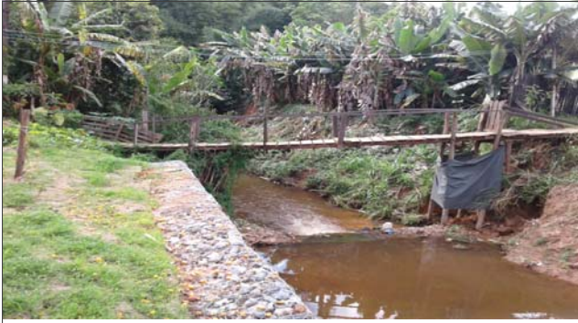
Foto: 1635959521317.jpg ID: 11 Visão geral da área, Visão geral da drenagem
