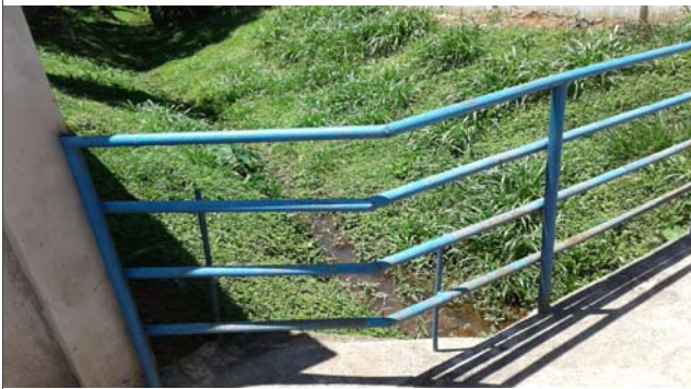
Foto: 1636030419492.jpg ID: 23 Visão geral da drenagem
