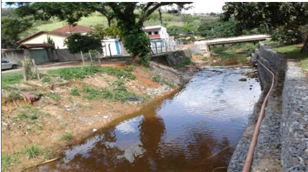
Foto: 163595952147.jpg ID: 12 Visão geral da drenagem
