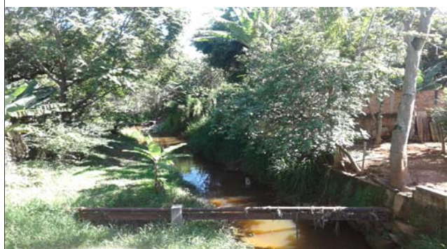
Foto: 1636025452206.jpg ID: 14 Detalhe do canal
