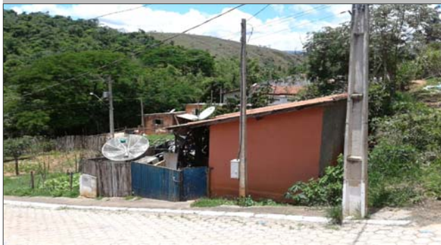
Foto: 1636032902094.jpg ID: 31 Visão geral do setor, Moradia sujeita a risco de escorregamento, Talude de corte com solo exposto
