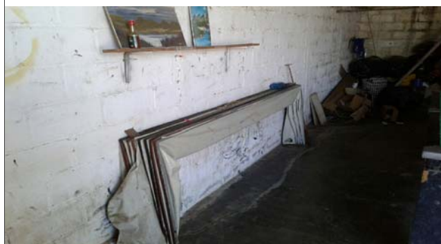
Foto: 1636027654529.jpg ID: 15 Evidência de movimentação no terreno
