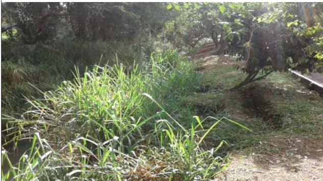
Foto: 1652722254777.jpg ID: 12 Visão geral da drenagem
