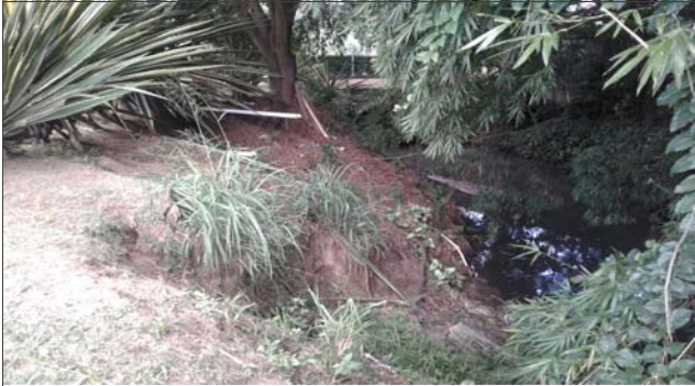
Foto: 1652721513331.jpg ID: 11 Visão geral da drenagem
