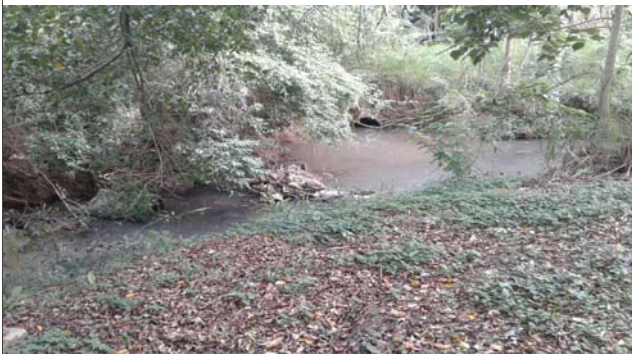
Foto: 1652722436541.jpg ID: 13 Visão geral da drenagem
