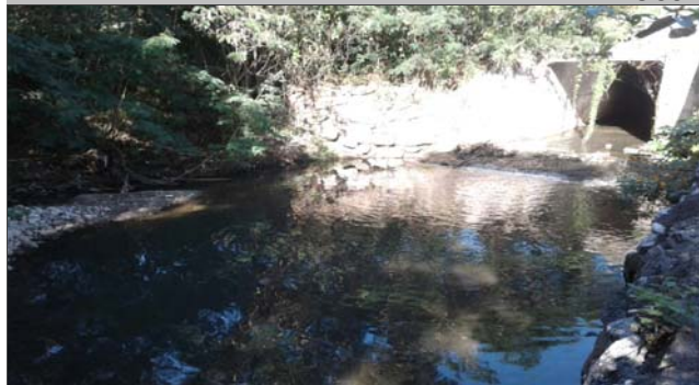
Foto: 1652810835368.jpg ID: 11 Visão geral do setor, Visão geral da drenagem, Detalhe do canal, Detalhe para intervenções no canal
