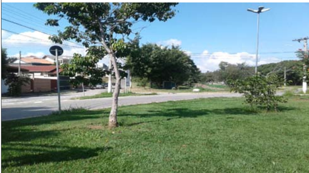
Foto: 1652794727833.jpg ID: 13 Visão geral da área, Visão geral da drenagem, Limite da área atingida pelo processo, Imóveis afetados pelo processo
