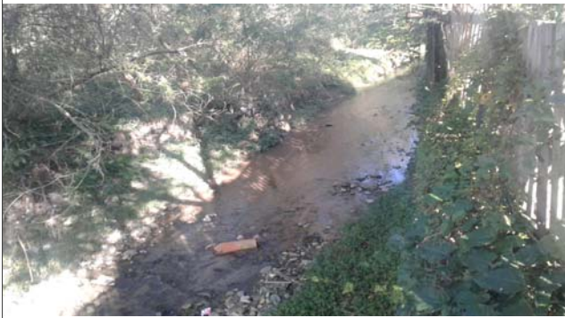
Foto: 1652896995236.jpg ID: 14 Visão geral da drenagem
