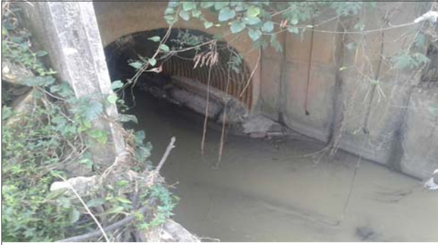
Foto: 1652894965921.jpg ID: 11 Detalhe do canal
