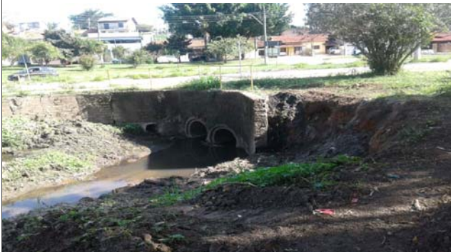
Foto: 1652793533631.jpg ID: 12 Visão geral da drenagem, Detalhe do canal
