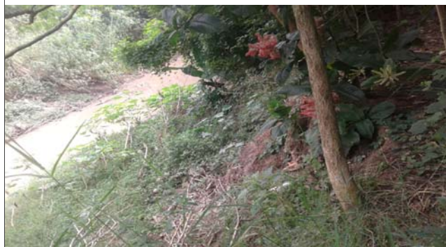
Foto: 1652280560161.jpg ID: 13 Detalhe do canal, Detalhe para processo de erosão, Detalhe para processo de solapamento no talude, Depósito de escorregamento pretérito, Presença de cicatriz de escorregamento pretérito, Evidência de movimentação no terreno, Formação de processo erosivo
