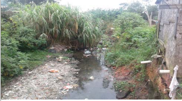
Foto: 1652360085936.jpg ID: 21 Depósito de escorregamento pretérito, Presença de cicatriz de escorregamento pretérito, Formação de processo erosivo, Presença de vazamento de tubulação de água/esgoto, Moradia sujeita a risco de solapamento
