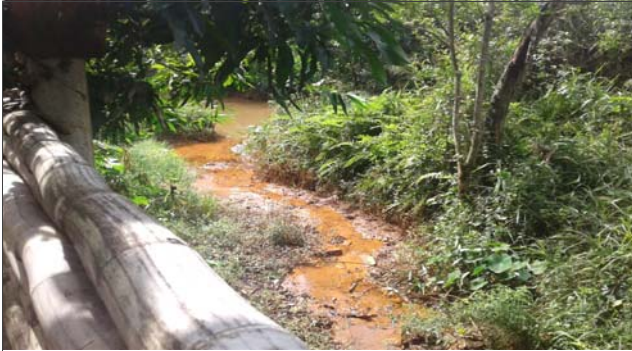
Foto: 1652367666542.jpg ID: 21 Detalhe do canal
