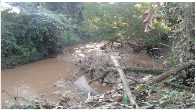
Foto: 1651604004507.jpg ID: 14 Visão geral da drenagem
