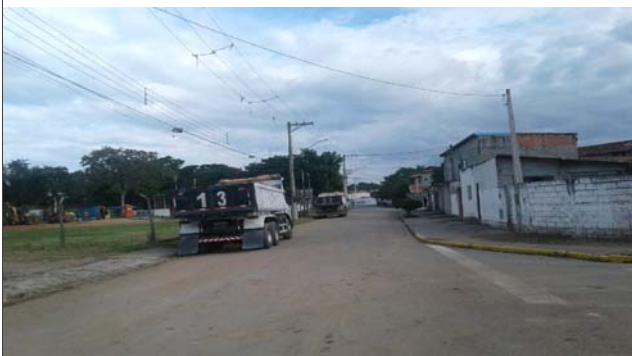
Foto: 1652291250381.jpg ID: 13 Visão geral da área, Imóveis afetados pelo processo
