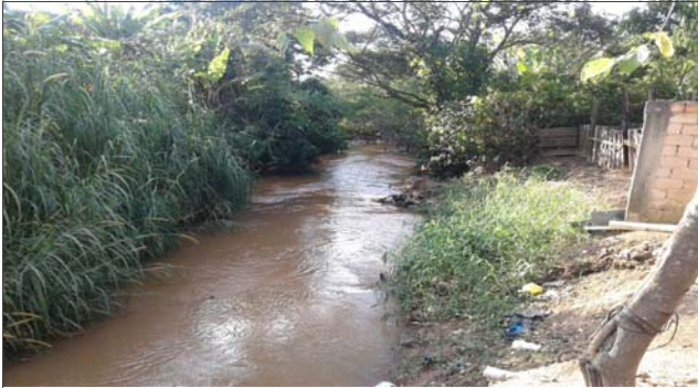
Foto: 1651602806946.jpg ID: 11 Visão geral da drenagem
