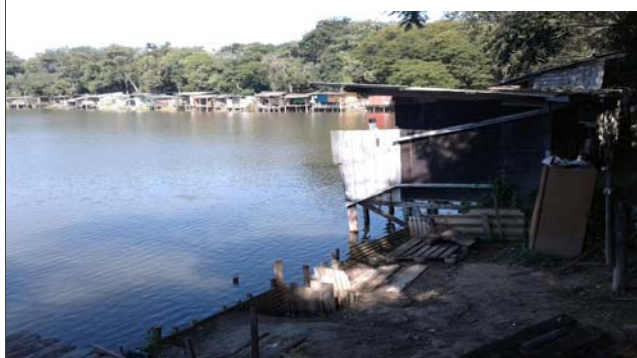
Foto: 1652189111728.jpg ID: 24 Visão geral da área, Imóveis afetados pelo processo
