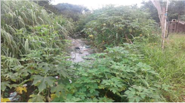
Foto: 1652359889397.jpg ID: 12 Detalhe do canal
