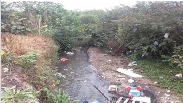
Foto: 1652359970440.jpg ID: 13 Visão geral da drenagem
