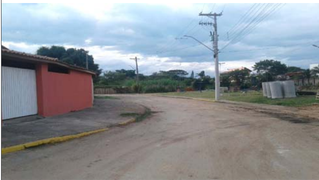
Foto: 1652291211968.jpg ID: 12 Visão geral da área, Imóveis afetados pelo processo
