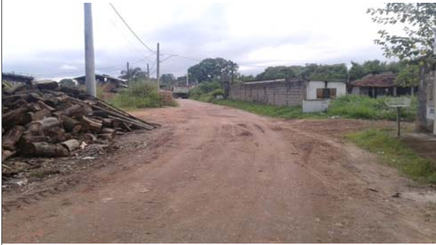
Foto: 1652366927060.jpg ID: 12 Visão geral da drenagem
