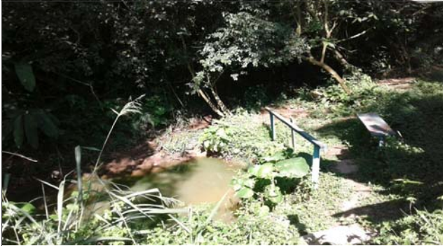
Foto: 1652200034775.jpg ID: 31 Detalhe do canal
