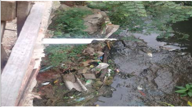
Foto: 1652360213837.jpg ID: 23 Presença de cicatriz de escorregamento pretérito, Evidência de movimentação em estruturas
