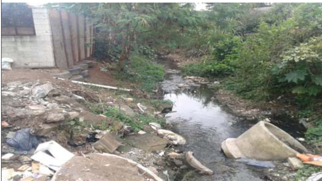
Foto: 1652362227479.jpg ID: 15 Detalhe do canal
