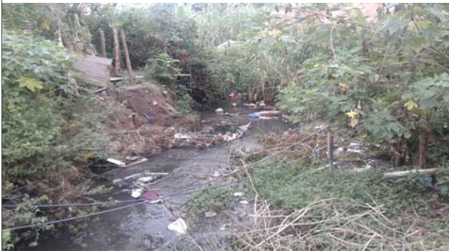
Foto: 1652362118959.jpg ID: 14 Detalhe do canal
